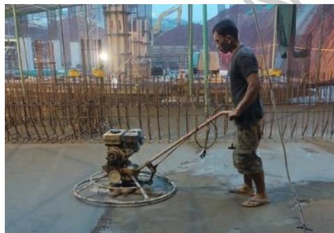
**Gambar 3. 15** Pekerjaan *Floor Hardener*
