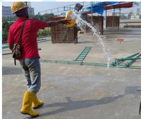
**Gambar 3. 33** Perawatan Beton
