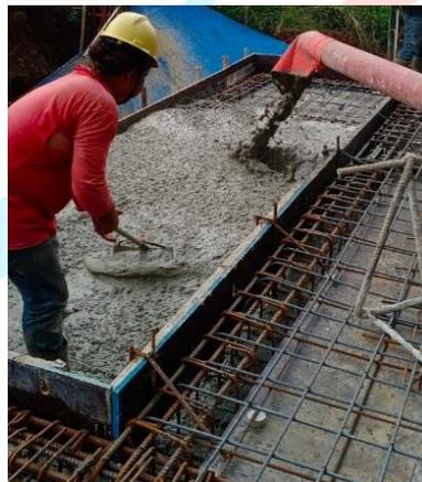
Gambar 3. 22 Pengecoran Pelat Lantai dan Balok
