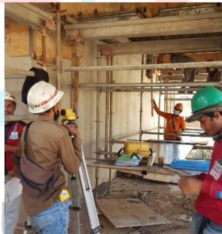
**Gambar 3. 16** Pengaturan Elevasi Cetakan Beton
