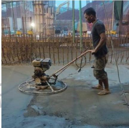
Gambar 3. 31 Pekerjaan *Floor Hardener*
