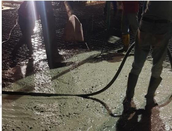
8. Setelah beton dituangkan ke lokasi pengecoran, beton digaruk secara merata pada area pelat lantai dan balok, kemudian permukaan pelat lantai diatur ketinggian elevasi dengan alat ukur *Waterpass*. Setelah selesai, sebelum beton mengering dilakukan proses pekerjaan *floor hardener*.
