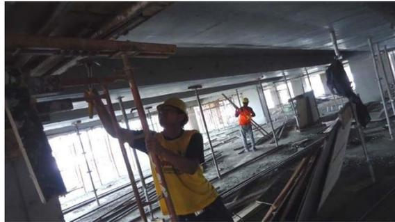
**Gambar 3. 32** Pekerjaan Bongkar Cetakan
