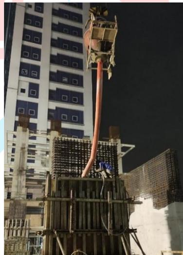
**Gambar 3. 36** Pemadatan Pengecoran Pada Dinding Geser
