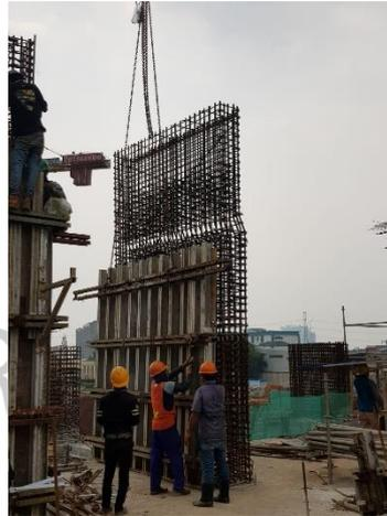
**Gambar 3. 43** Pemasangan Cetakan Dinding Geser
