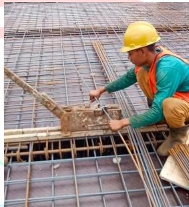
**Gambar 3. 18** Pemotongan Besi Tulangan
