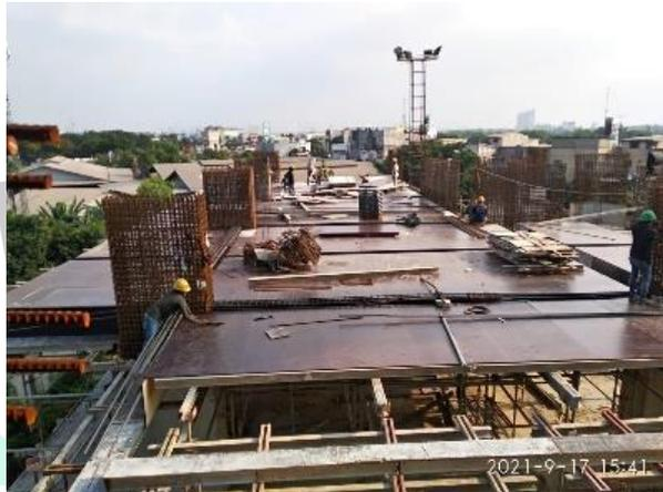
**Gambar 3.17** Pekerjaan Cetakan Balok dan Pelat Lantai
