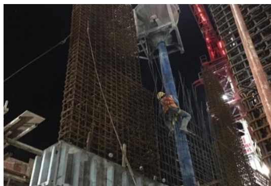
Gambar 0.36 Pengecoran Dengan Bantuan Concrete Bucket
