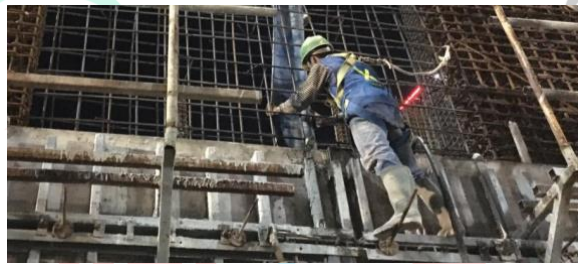
Gambar 0.5 Pekerja Memakai Safety Belt
