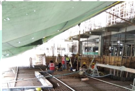
Gambar 0.57 Pemasangan Tenda di Area Oceanarium
