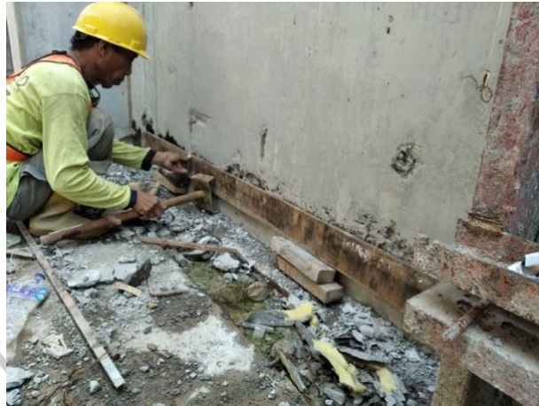
Gambar 0.58 Pemasangan Bekisting untuk Treatment Beton Keropos
