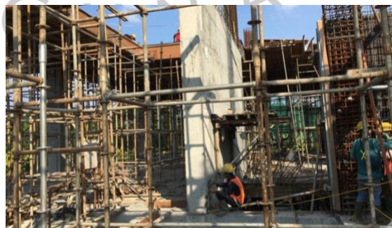
Gambar 0.40 Perbaikan Shear Wall Menggunakan Mortindo M 350
