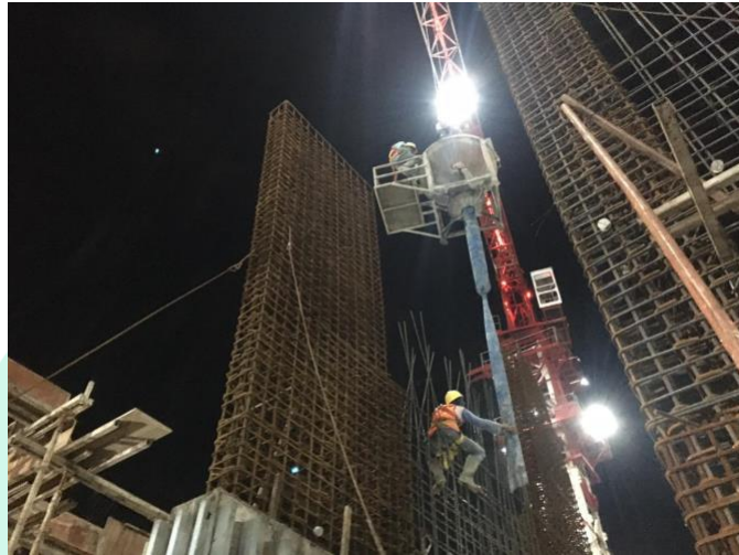
Gambar 0.16 Pipa Tremie Mempermudah Pengecoran Shear Wall
