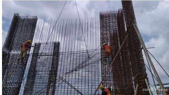
Gambar 0.42 Pemasangan Tulangan di Core Wall
