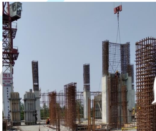
Gambar 0.25 Proses Penyambungan Tulangan Shear Wall
