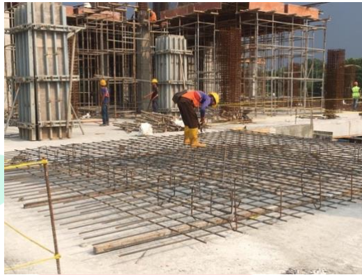
Gambar 0.24 Proses Fabrikasi Shear Wall
