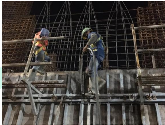
Gambar 0.37 Pekerja Menggunakan Alat Vibrator
