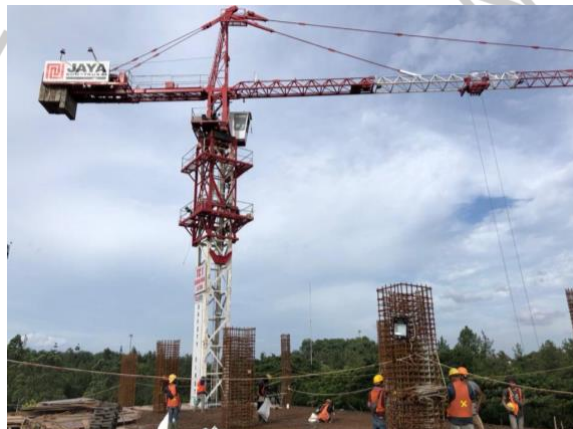
Gambar 0.13 Tower Crane 1 dengan Kapasitas Maksimal 1,6 Ton
