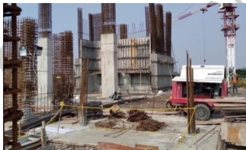
Gambar 0.45 Air Compressor Untuk Pembersihan Area
