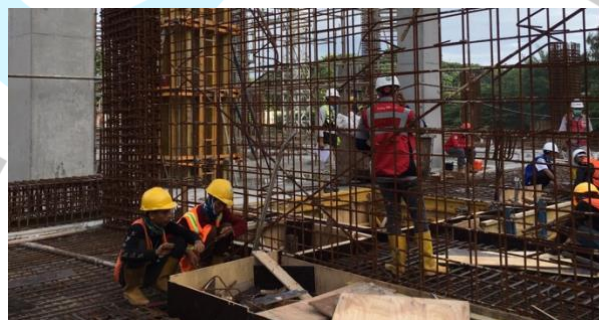
Gambar 0.4 Para Pekerja Menggunakan Safety Helmet
