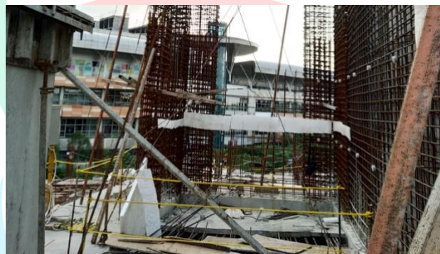
Gambar 0.43 Stek Tangga yang Ditutup dengan Styrofoam
