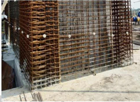
Gambar 0.44 Beton Decking di Core Wall
