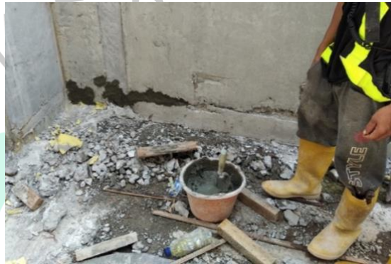
Gambar 0.54 Beton Keropos
