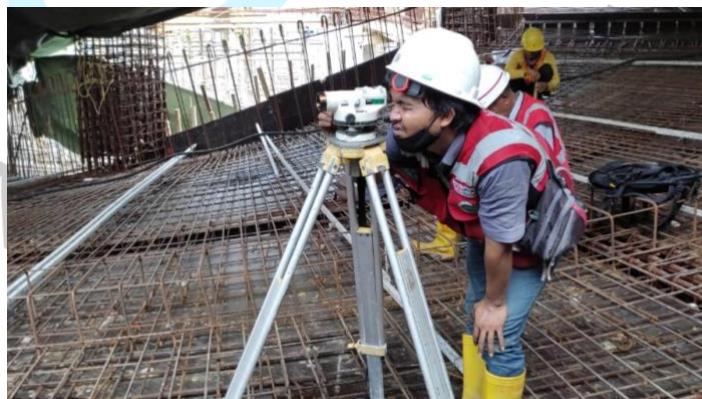
Gambar 0.17 Proses Pengukuran Menggunakan Automatic Level
