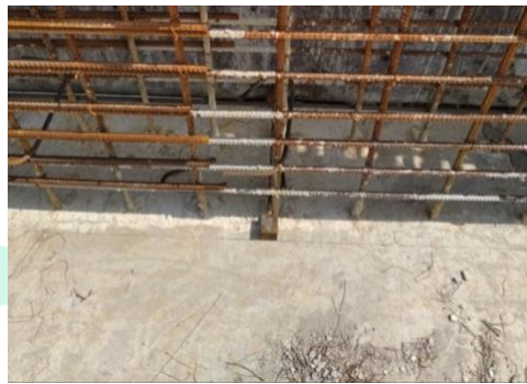
Gambar 0.28 Sepatu Kolom di Shear Wall
