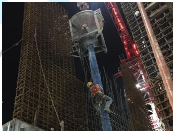
Gambar 0.15 Concrete Bucket Untuk Pengecoran Shear Wall
