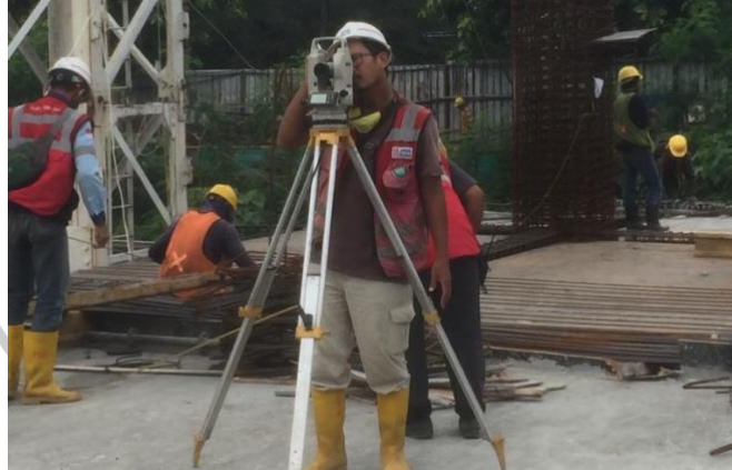
Gambar 0.18 Proses Pengukuran Menggunakan Theodolite
