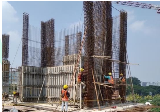
Gambar 0.47 Pemasangan Bekisting Core Wall
