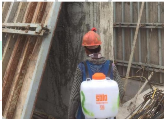
Gambar 0.39 Proses Curing di Shear Wall
