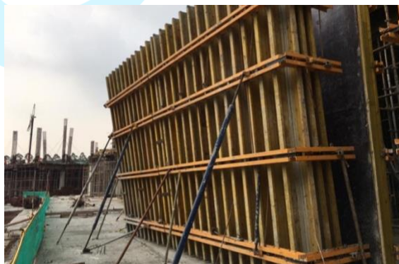
Gambar 0.21 Bekisting Knock Down Untuk Shear Wall
