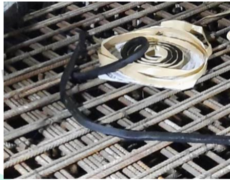
Gambar 0.22 Waterstop yang Digunakan di Proyek
