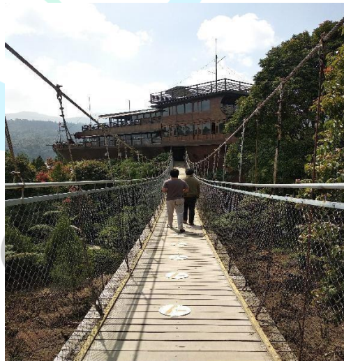
Gambar 2.3.3.2 Jembatan Gantung Pinisi
