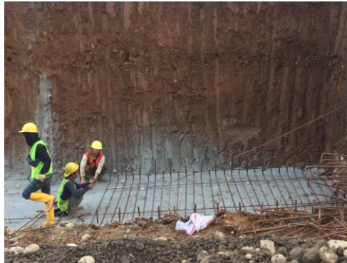
Gambar 3.21 Pengecoran dan Pembesian Foot Plat (Sumber : Data Pribadi)
