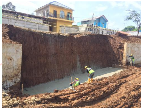
Gambar 3.20 Lantai Kerja (LC) (Sumber : Data Pribadi)
