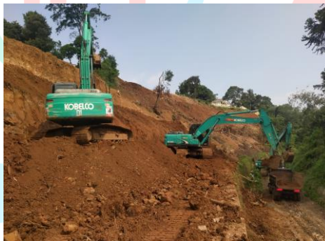
Gambar 3.29 Pemindahan Tanah ke lokasi yang akan ditimbun (Sumber : Data Pribadi)
