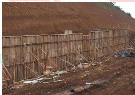
Gambar 3.24 Pemasangan Bekisting pada Body Retaining Wall (Sumber : Data Pribadi)
