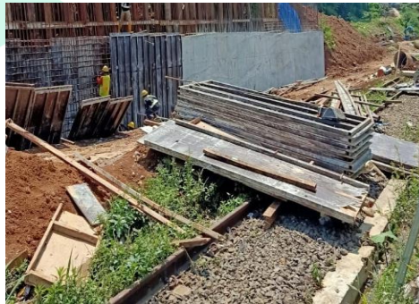
Gambar 3.14 Bekisting (Sumber : Data Pribadi)
