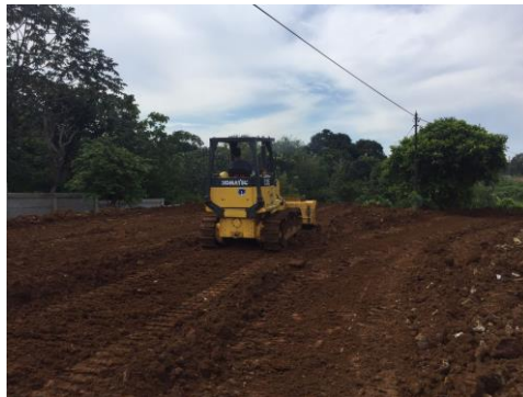
Gambar 3.30 Pemadatan Tanah (Sumber : Data Pribadi)
