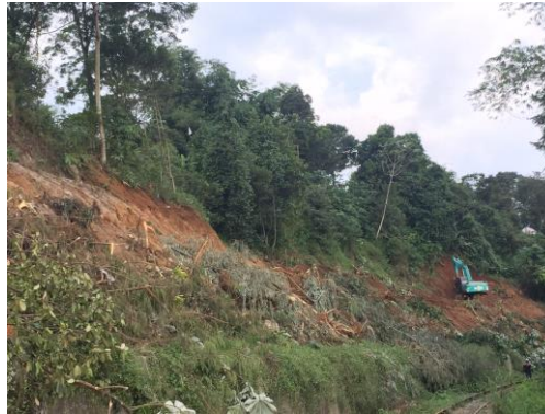
Gambar 3.27 Pembuatan Jalan Masuk atau Akses (Sumber : Data Pribadi)
