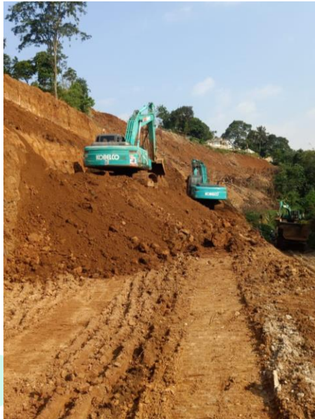
Gambar 3.28 Pekerjaan Galian STA 6+600 (Sumber : Data Pribadi)
