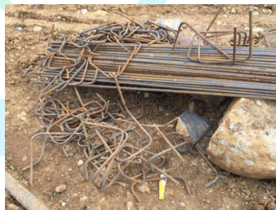
Gambar 3.11 Baja Tulangan (Sumber : Data Pribadi)
