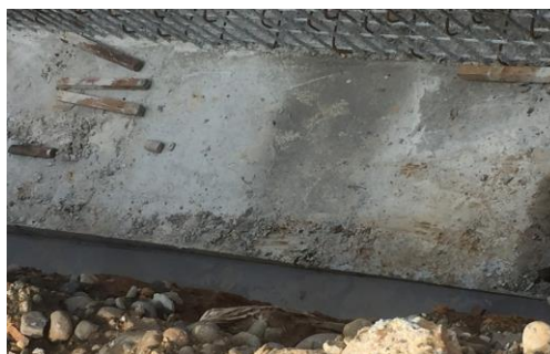
Gambar 3.22 Pengecoran dan Pemasangan Bekisting Foot Plat (Sumber : Data Pribadi)
