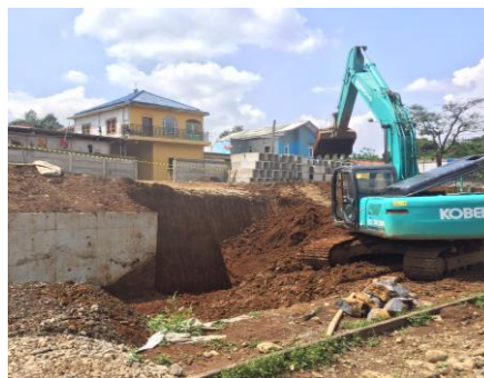
Gambar 3.19 Proses Penggalian dengan Alat Berat Excavator (Sumber : Data Pribadi)
