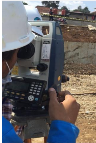
Gambar 3.16 Pengukuran dan Pematokan Area (Sumber : Data Pribadi)
