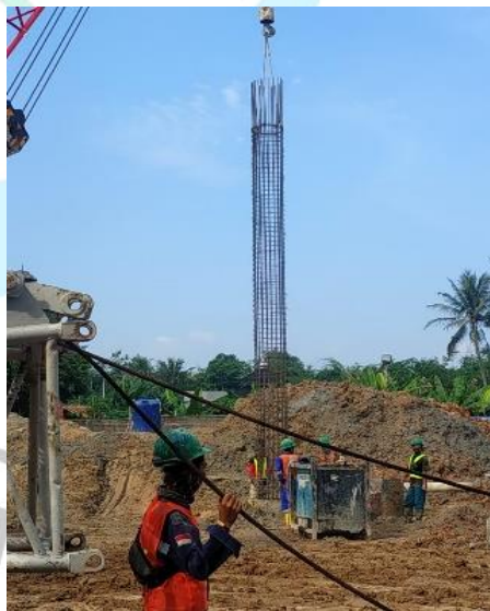
Gambar 3. 44 Instalasi Tulangan Pile
