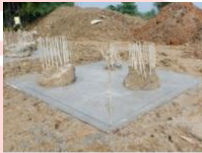
Gambar 3. 47 Pengecoran Lantai Kerja
