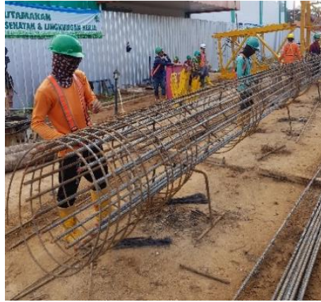
Gambar 3. 43 Perakitan Tulangan Bored Pile
