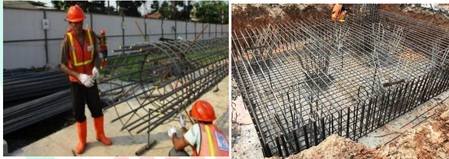
Gambar 3. 12 Tulangan Besi Bored Pile & Pile Cap (Sumber : Data Proyek RSUD Banten)
