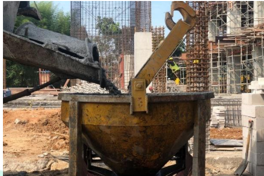
Gambar 3. 11 Pemindahan Ready Mix dari truck ke bucket cor
