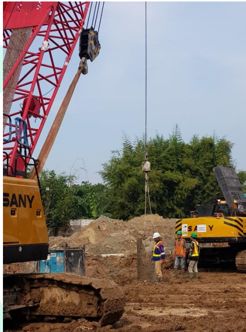
Gambar 3. 42 Pemasangan cassing bored pile
