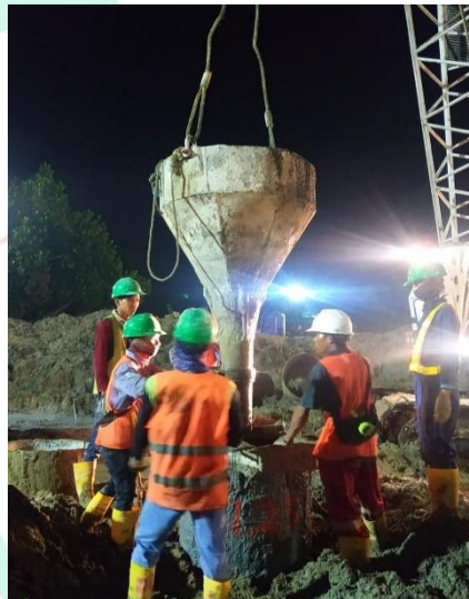
Gambar 3. 45 Pengecoran Pile
