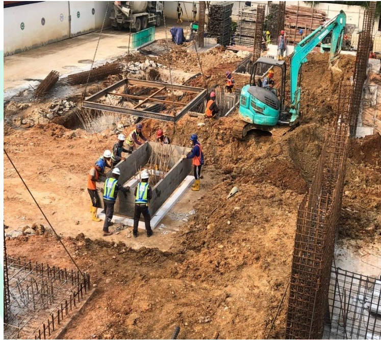
Gambar 3. 48 Pemasangan Bekisting Batako
