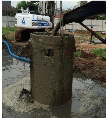
Gambar 3. 46 Pengangkatan Cassing
