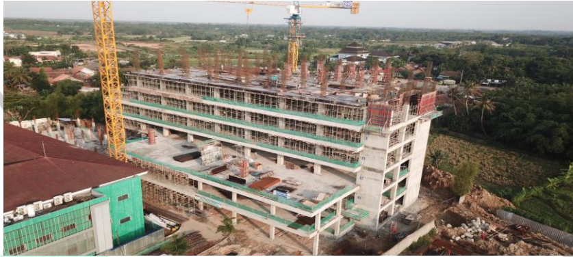
Gambar 3. 5 Tampak Safety Railing dan Safety Net pada Gedung
