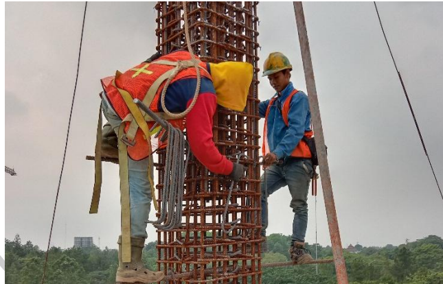
Gambar 3. 4 Pekerja Menggunakan Safety Belt / Body Harness
