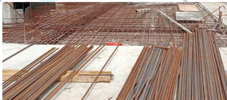
Gambar 3. 12 Besi Tulangan Di Lapangan
