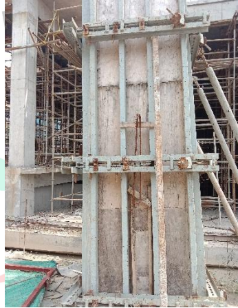
Gambar 3. 23 Bekisting Kolom
