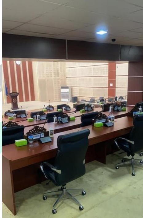
Gambar 3.8 Persiapan & pengontrolan di ruang rapat paripurna DPRD Kota Tangerang Selatan
