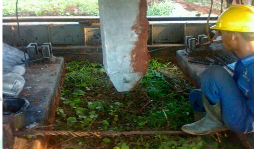
Gambar 3. 19 Persiapan Pemancangan
