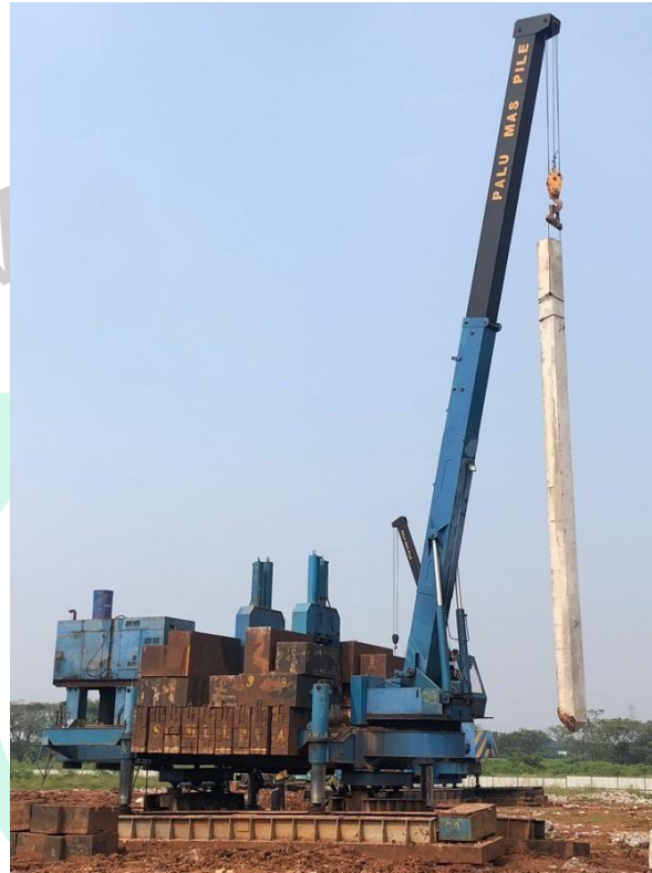
Gambar 3. 18 Pemancangan Menggunakan Alat Hydraulic Static Pile Driver (HSPD)
