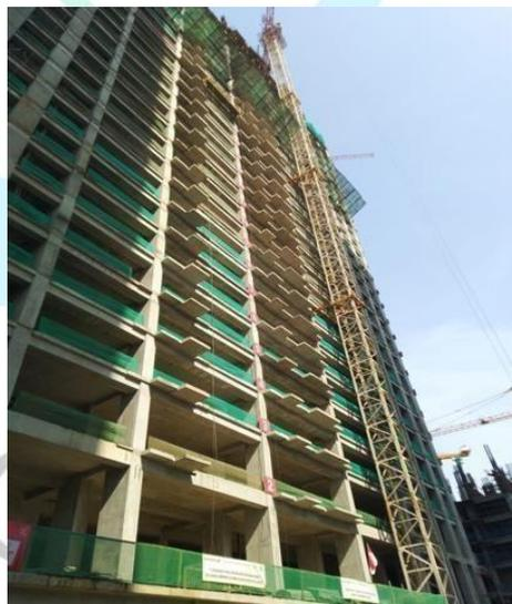
**Gambar 3. 4 *Safety Wing* dan *Safety Railing***
