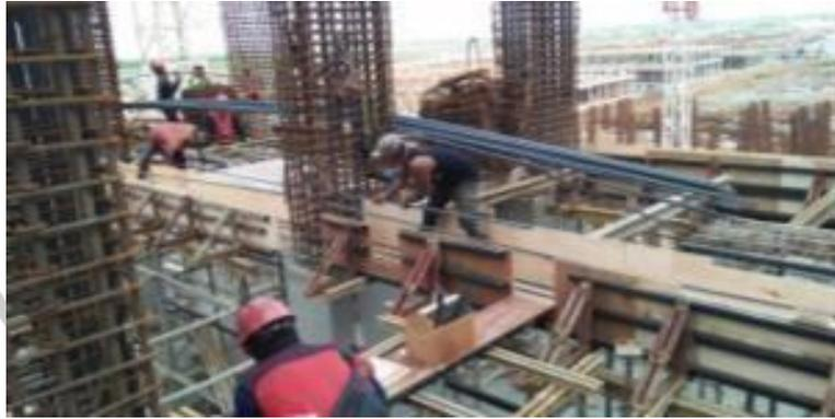
**Gambar 3. 88 Pemasangan Bekisting Balok & Pelat Lantai**
