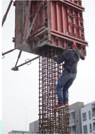
**Gambar 3. 76 Pemasangan Bekisting Kolom**
