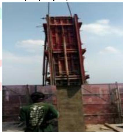
Gambar 3. 82 Pelepasan Bekisting Kolom
