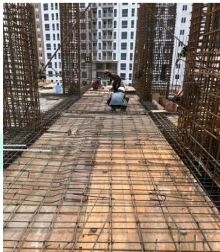
**Gambar 3. 34 Bekisting Balok dan Plat Lantai**
