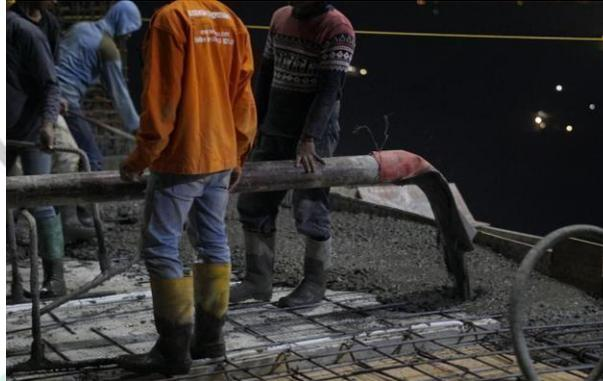
**Gambar 3. 94 Pengecoran Pelat Lantai**
