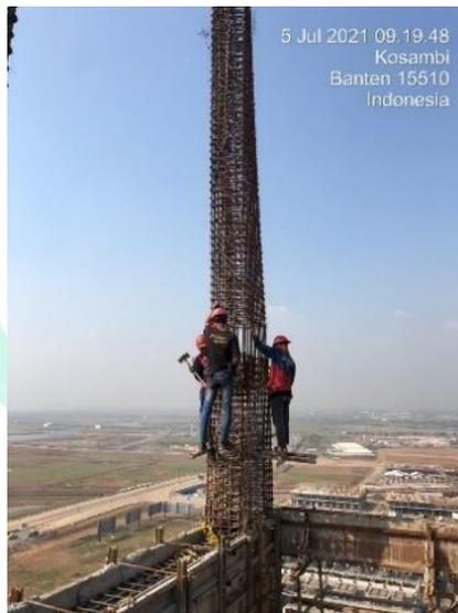
**Gambar 3. 73 Pemasangan Tulangan Kolom**
