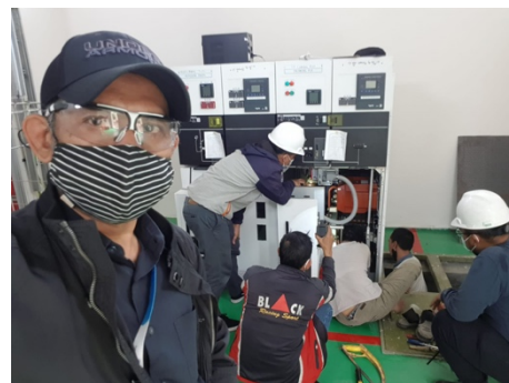
Gambar 2.4. Kegiatan Pemeliharaan Infrastruktur Panel MV
