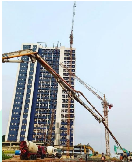
Gambar 2. 9 Situasi PT Totalindo Eka Persada Proyek Kingland Avenue
