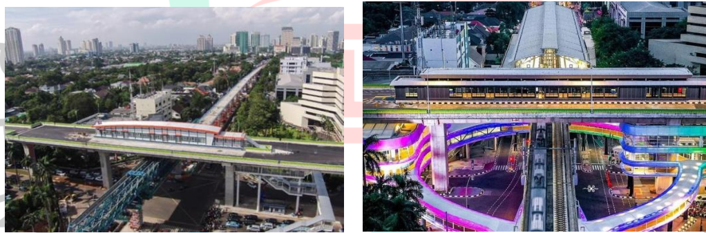
Gambar 4.2 Penampakan Halte Transjakarta CSW dan Stasiun MRT Asean Sebelum Pembangunan (kiri) dan setelah dibangun (kanan), (Sumber : https://megapolitan.kompas.com/ (atas) dan https://finance.detik.com/ (bawah), diakses pada 10 September 2021)
