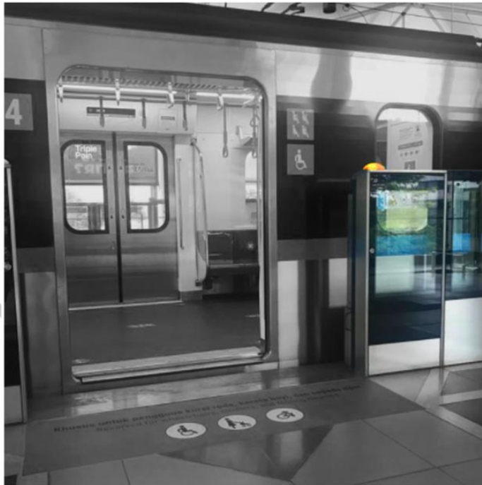
Gambar 4.30 Lampu Indikator pada Pagar Pembatas MRT Sumber: Hasil Olahan Pribadi (2021)
