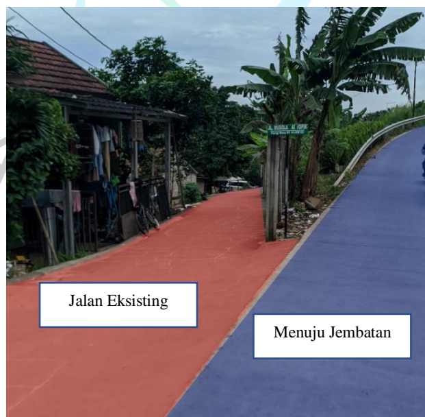
Gambar 4.8 : Konfigurasi Jalan di Ujung Selatan Jembatan B (Sumber : Dokumentasi Pribadi,2021)
