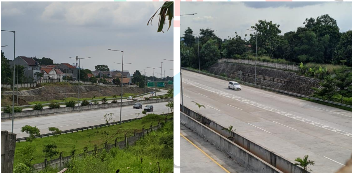
Gambar 4.15 : Dinding penahan pada pemotongan kontur (Sumber : Dokumentasi Pribadi,2021)
