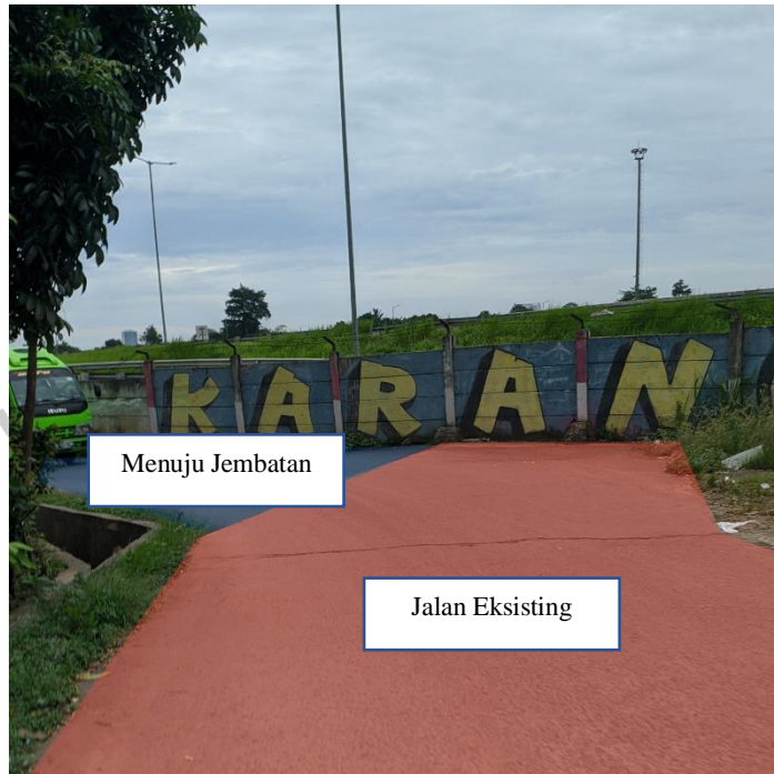
Gambar 4.5 : Sisi Selatan Jembatan A, (Sumber : Dokumentasi Pribadi,2021)
