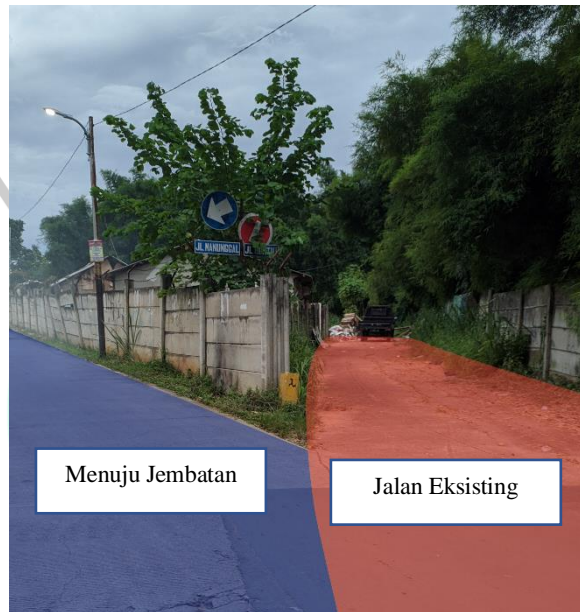
Gambar 4.9: Konfigurasi Jalan di Ujung Utara Jembatan B ( Sumber : Dokumentasi Pribadi,2021)
