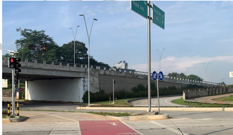
Gambar 4. 12 Penggunaan wayfinding di Boulevard Bintaro (Sumber: Dokumen Pribadi, 2021)
