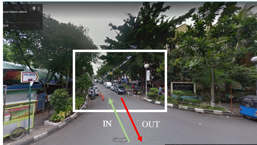
Gambar 4.1 Pintu Gerbang Utama Rusun Apron Kemayoran. Kondisi gerbang utama Rusun Apron sejak terbangun sampai sebelum adanya parking gate, hanya menggunakan portal dan dapat diakses oleh siapapun.
