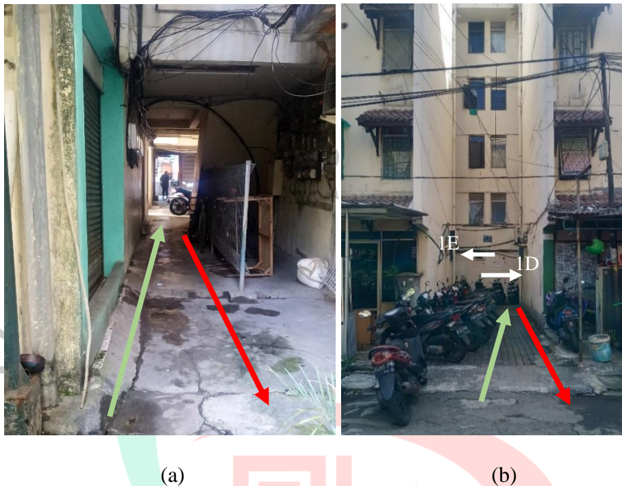
Gambar 4.21 (a) Akses Masuk Samping Gedung. (b) Akses Masuk Depan Gedung
