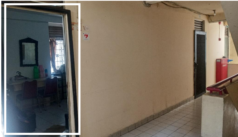
Gambar 4.22 Koridor Rusun Apron Kemayoran. Kondisi lantai hunian rusun yang tidak besar dan menyebabkan bentuknya menjadi circular. Penggunaan pola lantai hunian seperti ini, didukung juga dengan penggunaan pintu jaring semakin menambah adanya pengawasan alami dari penghuni.
