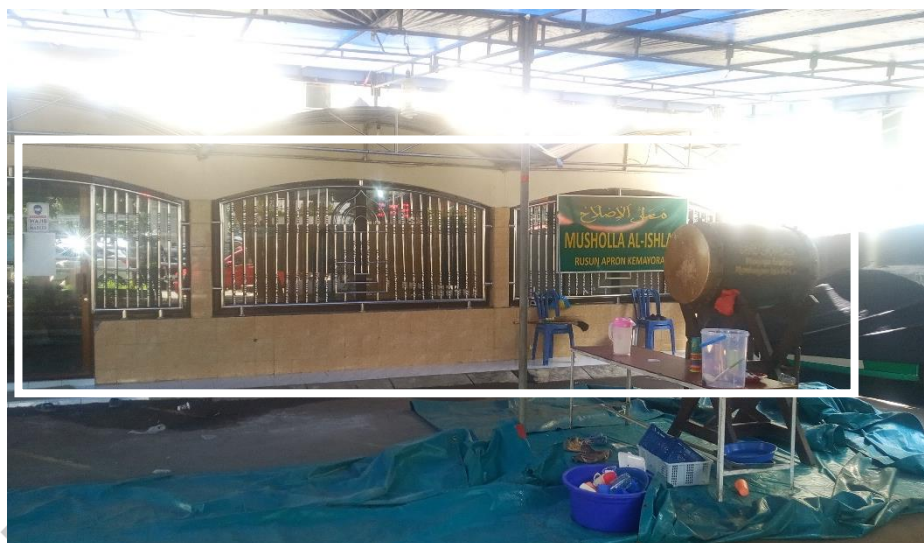
Gambar 4.20 Musholla Rusun Apron Kemayoran Sumber : (Dokumentasi Penulis, 2022)
