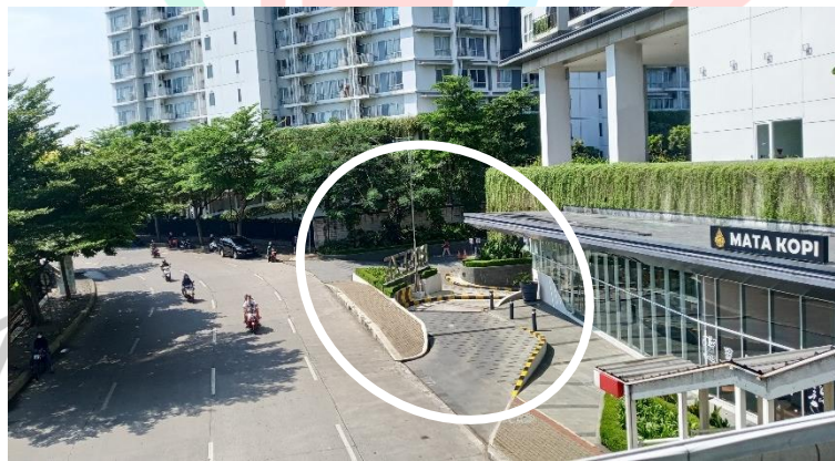
Gambar 4.9 Keadaan Existing Aksesibilitas Apartemen BB Sumber : (Dokumentasi Penulis,2022)
