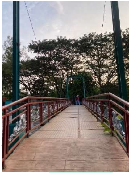
Gambar 4. 8 Fasilitas Jembatan Penyebrangan Taman kotaII BSD
