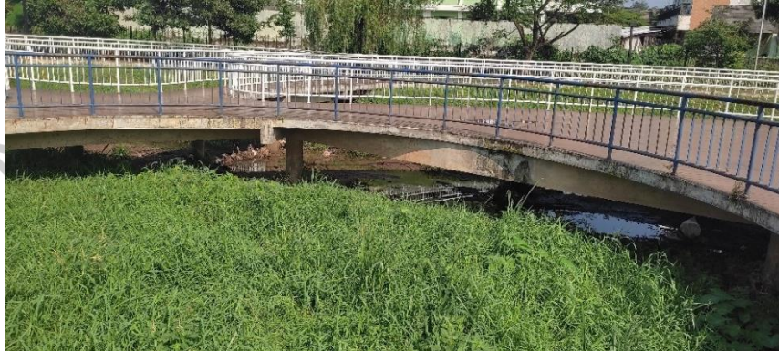
Gambar 4. 16 Rumput ilalang yang tumbuh di kolam retensi Sumber: Dokumentasi Pribadi, 2022
