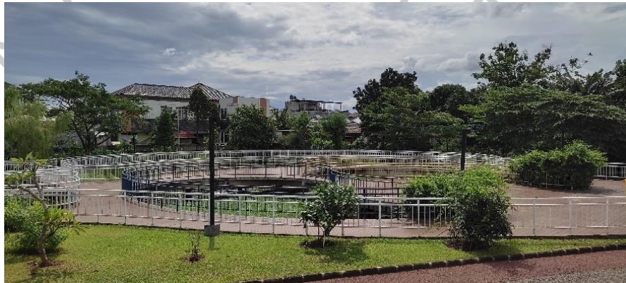
Gambar 4. 15 Fasilitas Kolam Retensi Sumber: Dokumentasi Pribadi, 2022
