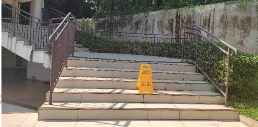
Gambar 4. 28 Peringatan lantai licin di Menara Pandang Sumber: Dokumentasi Pribadi, 2022
