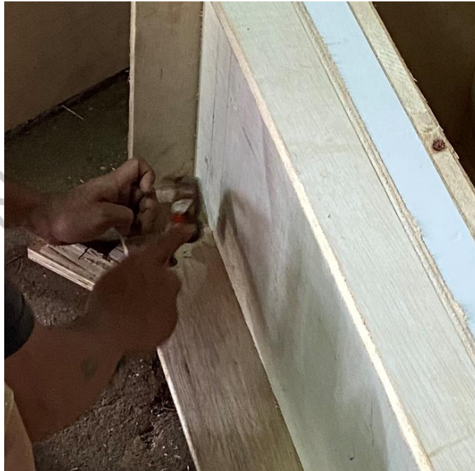
Gambar 4.56 Pemasangan engsel pivot
