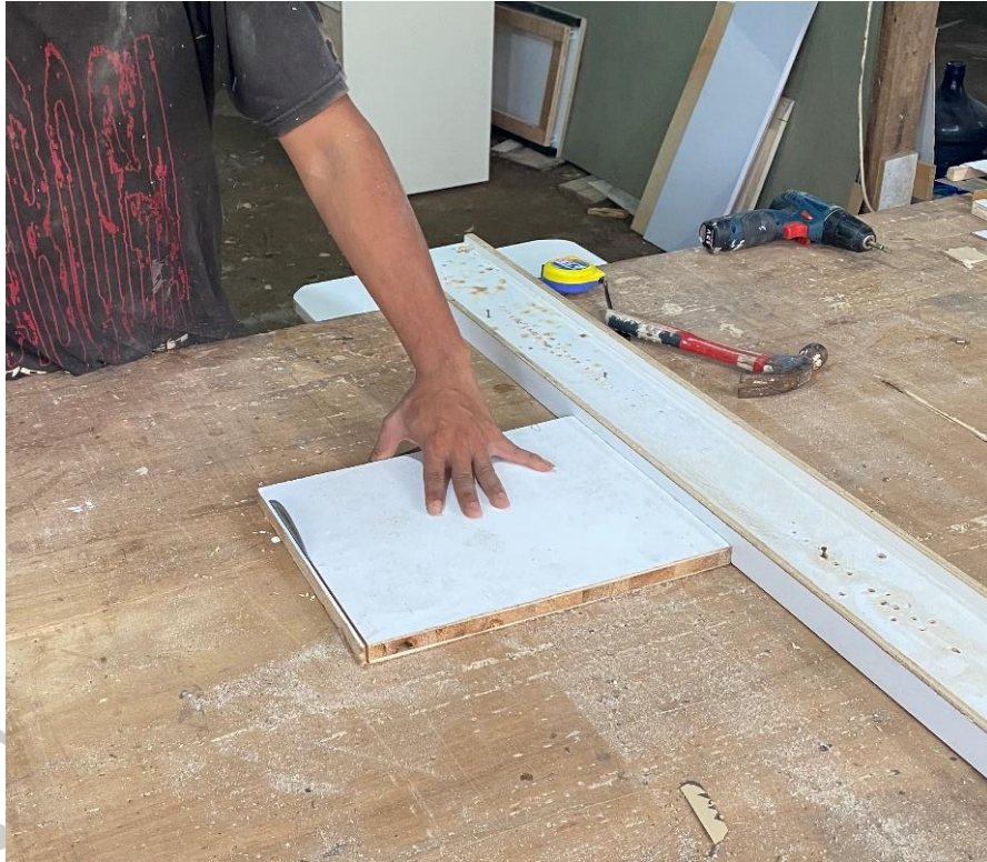
Gambar 4.54 Pemotongan Multiplek
