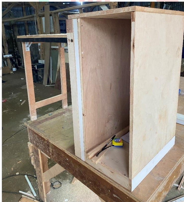
Gambar 4.59 Pengetesan dan pengecekan sebelum penempelan HPL
