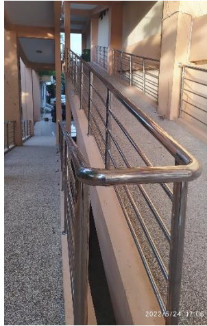
Gambar 4. 26 Fasilitas Ramp GOR Pasar Minggu Sumber: Dokumentasi Pribadi, 2022
