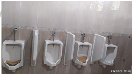
Gambar 4. 16 Fasilitas Ruang Ganti GOR Pasar Minggu Sumber: Dokumentasi Pribadi, 2022
