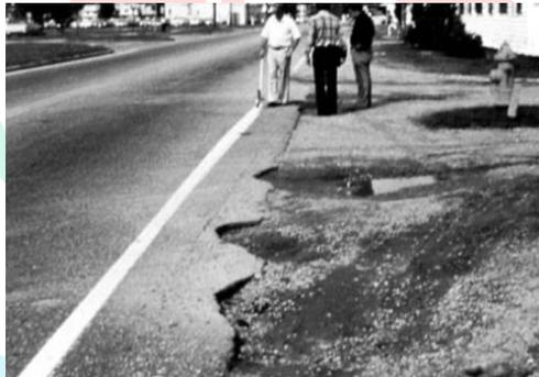
Gambar 2.3 Retak Pinggir (*Edge Crack*) (ASTM D 6433 – 07)
