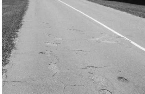
Gambar 2.15 Pengelupasan Lapis Permukaan (*Stripping*) (ASTM D 6433 – 07)
