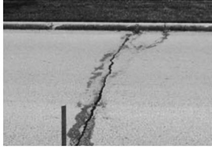
Gambar 2.6 Retak Sambungan Jalan (*Lane Joint Crack*)
