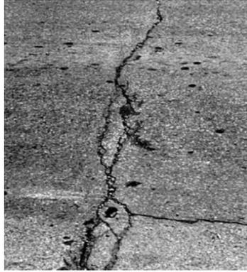
Gambar 2.4 Retak Refleksi Sambungan (Reflection Crack) (ASTM D 6433 – 07)
