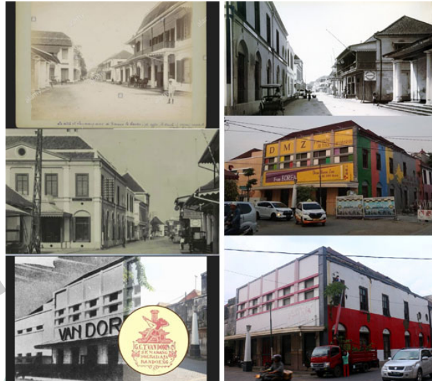
Gambar 1. 1: Perubahan muka jalan sebelum (kiri) dan sesudah (kanan) revitalisasi di sekitar bangunan bekas perusahaan percetakan Van Dorp, Kota Lama Semarang
