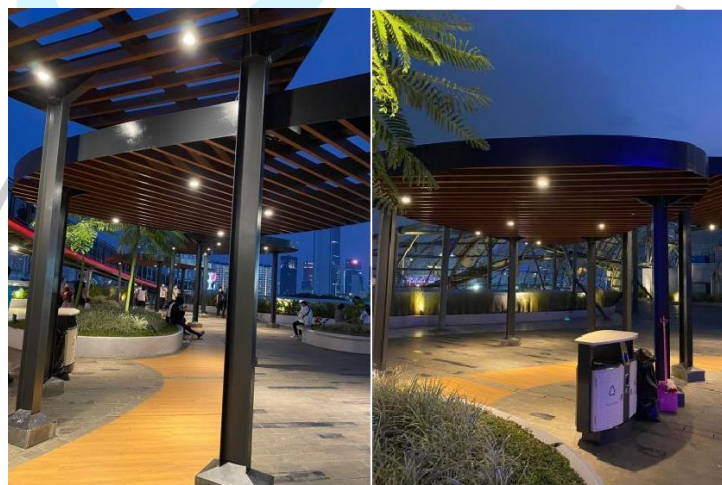
Gambar 4. 34 Kanopi pada Area Skywalk Senayan Park
