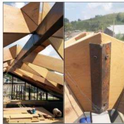
Gambar 2. 13 Elemen material kayu sebagai rangka atap dan besi sebagai pengikat rangka atap pada warung Citarasa.
