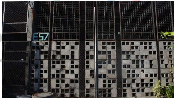
Gambar 4. 16 Bentuk bata roster custom pada rumah kos jilid dua. Sumber : (Data olahan pribadi, 2022)
