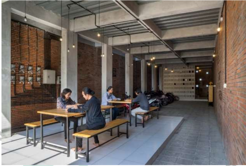
Gambar 4. 20 Material bata merah dan bata ringan yang di ekspos pada interiornya.
