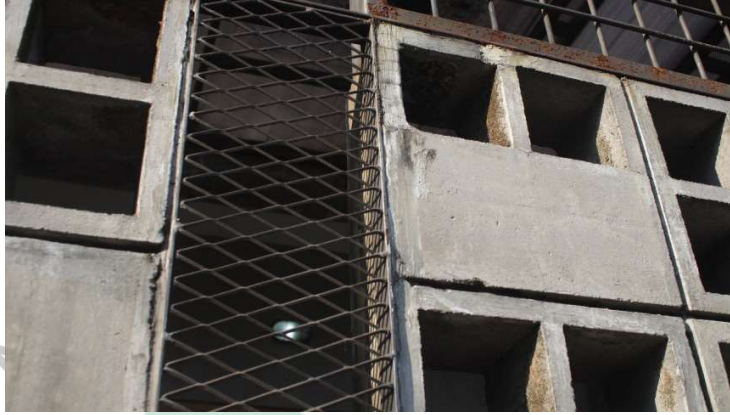
Gambar 4. 18 Detail material bata roster dan besi. Sumber : (Data olahan pribadi, 2022)
