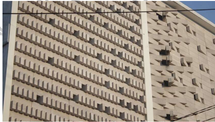
Gambar 4. 17 Bentuk fasad bata ringan pada rumah kos jilid empat dan lima.
