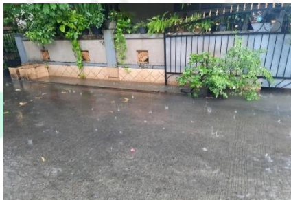
Gambar 4. 4 . Kondisi Drainase yang Tergenang (Dokumentasi Pribadi, 2022)
