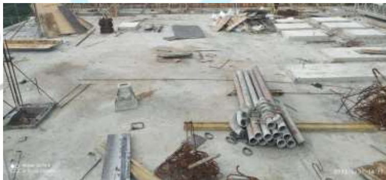
Gambar 4.12 Hasil Pengecoran Plat Lantai
