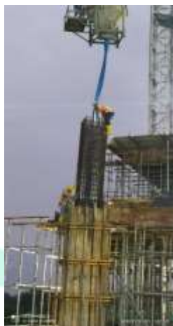
Gambar 4.10 Pekerjaan Pengecoran Kolom
