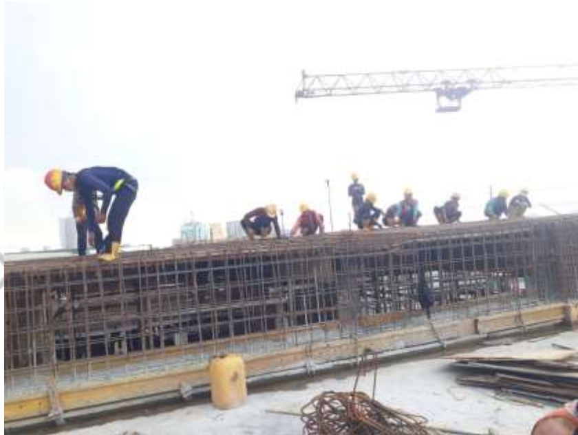
Gambar 4.11 Pembesian Balok
