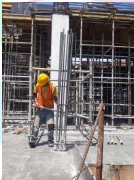
Gambar 4.9 Pekerjaan Pembesian Kolom
