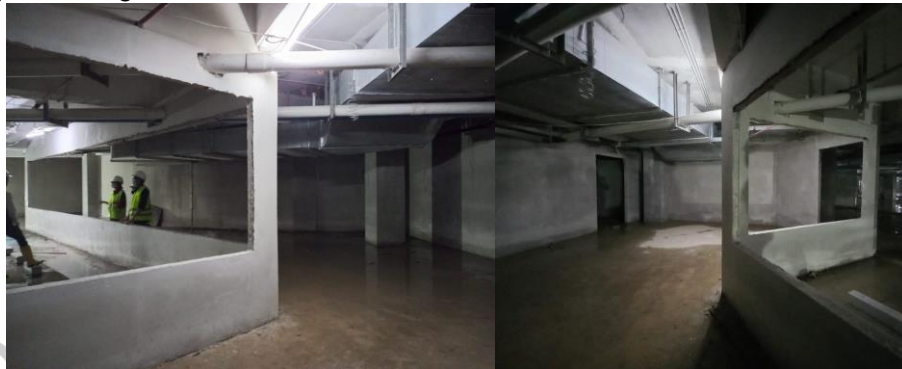
Gambar 3.8 Kondisi Eksisting Kantin B2
