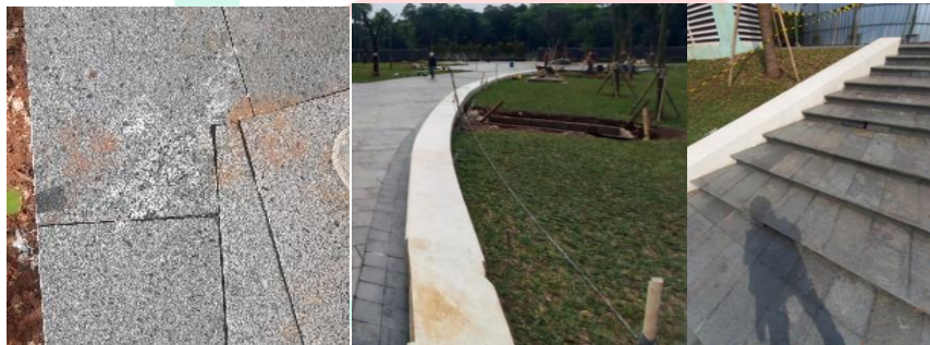
Gambar 3.6 Kondisi Teraso saat Pengecekan Sumber: Data Pribadi, 2022
