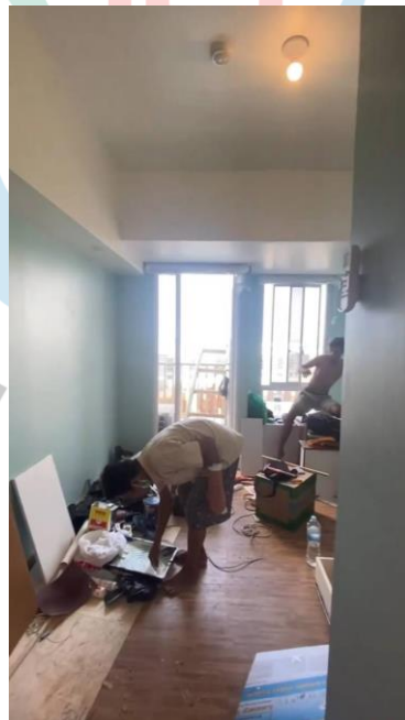
Gambar 3.16 Tahap pengerjaan pada ruangan Studio Apartemen “TOKYO PIK2”
