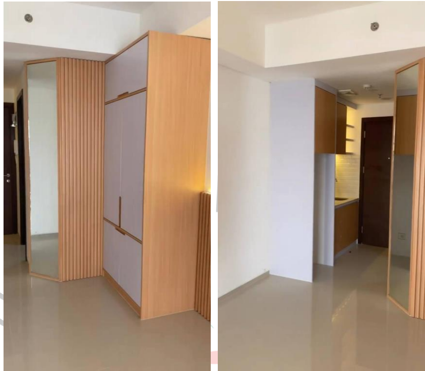
Gambar 3.44 dan 3.45 Tahap furnishing wall panel dan lemari pada ruangan Studio-Apartemen "Pacific Garden"
