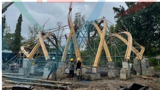
**Gambar 3.11 Pemasangan Arches dengan mobil derek**
