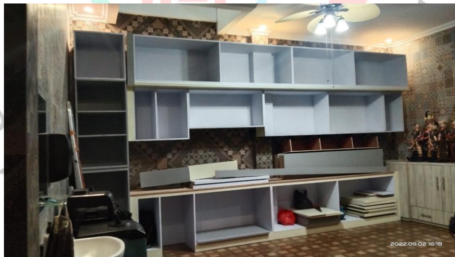
Gambar 3.8 Pemasangan Furnitur Penanggung jawab proyek, Rizky Natasha (2022)
