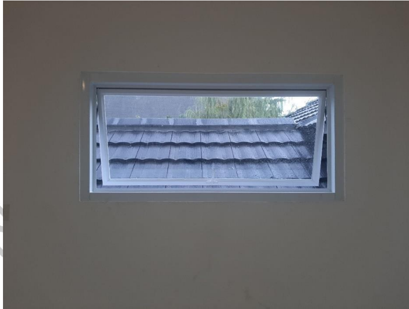
Gambar 3. 39 Jendela LT 2 Setelah Pemasangan Dokumentasi Pribadi ,2022
