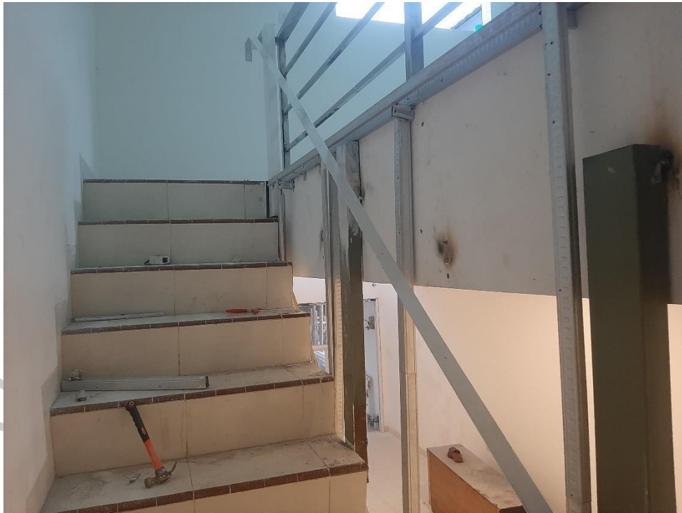
Gambar 3. 42 Gambar Kondisi Rangka Sudah Terpasang
