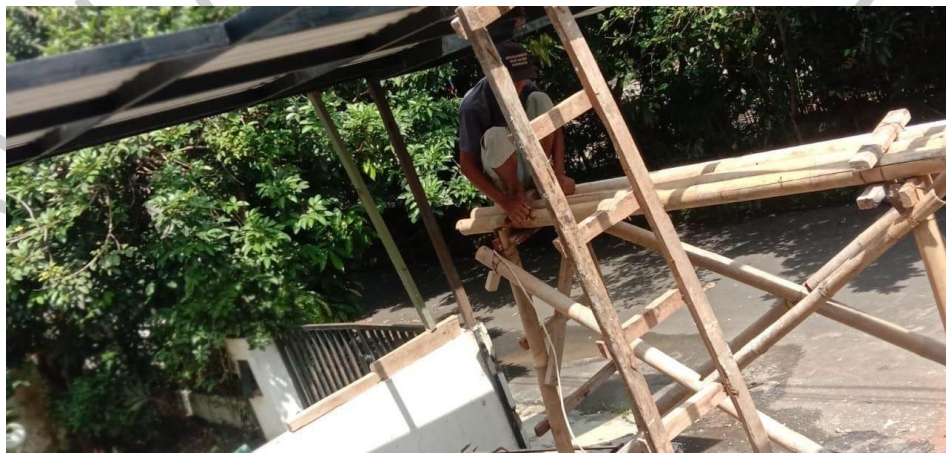
Gambar 3. 5 Gambar Pembongkaran Kanopi
