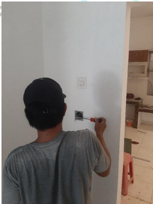
Gambar 3. 26 Proses Pemasangan Saklar
