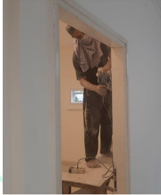
Gambar 3. 20 Proses Penghalusan Dokumentasi Pribadi ,2022
