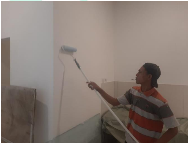
Gambar 3. 23 Proses Pengecatan Dokumentasi Pribadi ,2022
