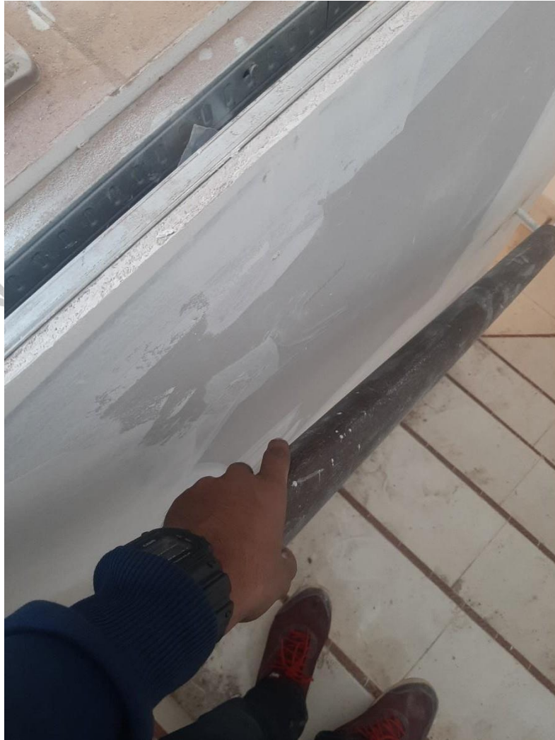
Gambar 3. 44 Kondisi Hand Railing Sudah Terpasang
