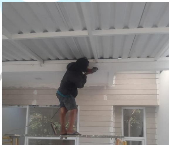
Gambar 3. 14 Finishing Kanopi Dokumentasi Pribadi, 2022
