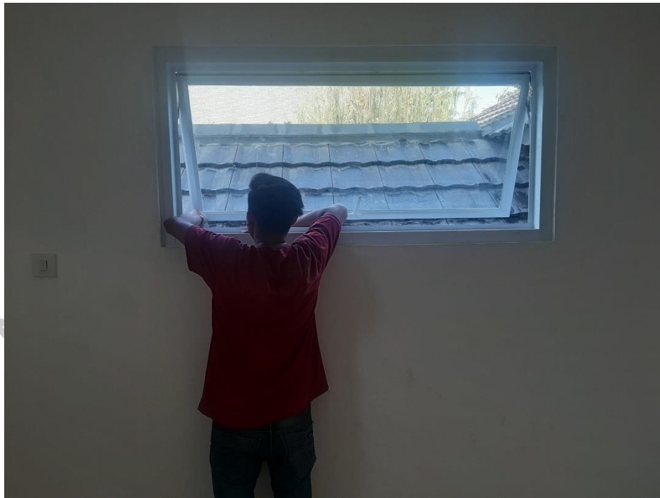
Gambar 3. 38 Pemasang Jendela LT 2
