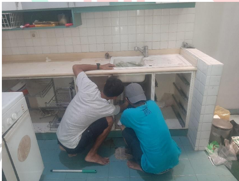
Gambar 3. 49 Proses Pembongkaran Dokumentasi Pribadi ,2022
