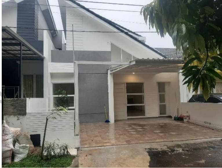
Gambar 3. 1 Fasade Bangunan Rumah Tinggal Villa Melati Mas
