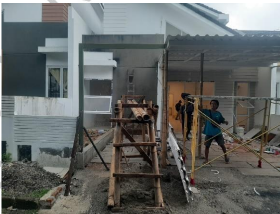
Gambar 3. 7 pembongkaran kanopi
