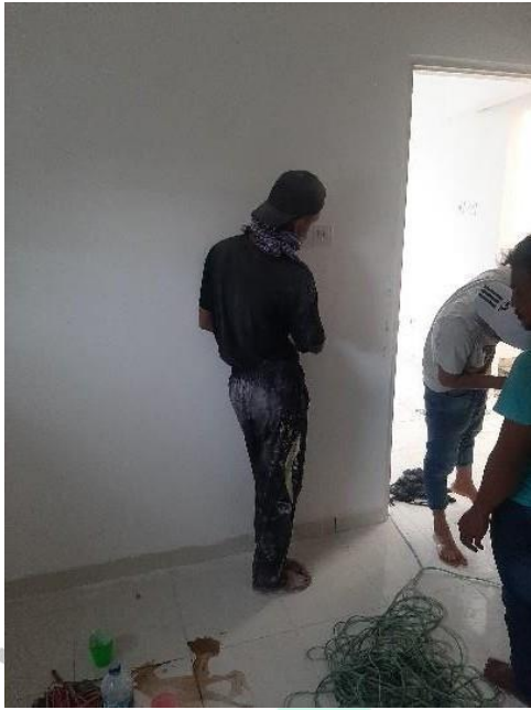
Gambar 3. 21 Proses Penghalusan Dokumentasi Pribadi ,2022
