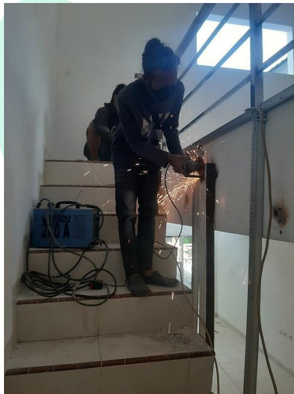
Gambar 3. 41 Pemasangan Rangka Railing
