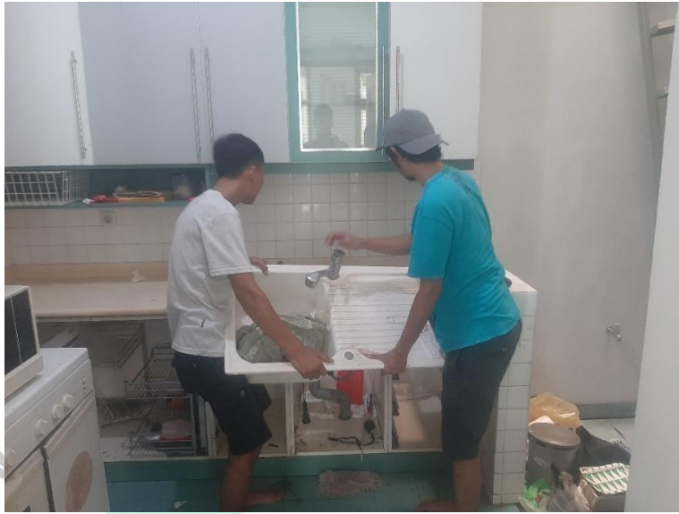
Gambar 3. 50 Proses Pembongkaran Sink Dokumentasi Pribadi ,2022
