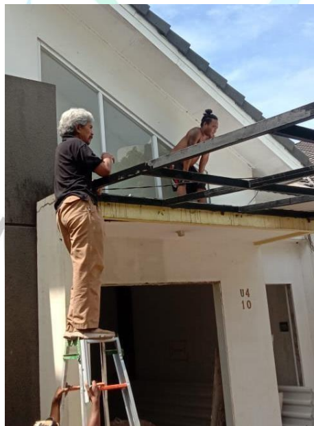
Gambar 3. 6 Pembongkaran Kanopi
