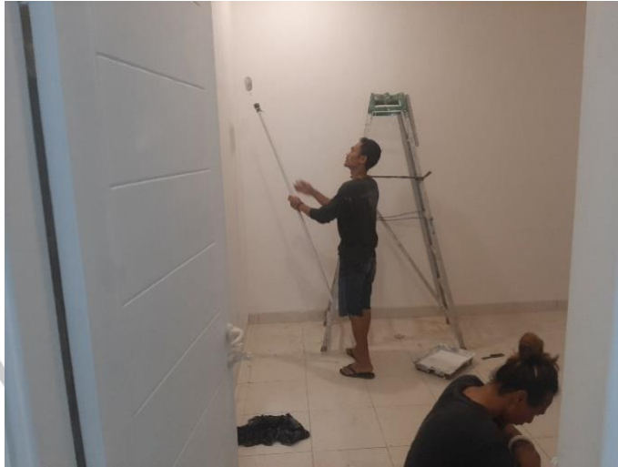
Gambar 3. 22 Proses Pengecatan Dokumentasi Pribadi ,2022
