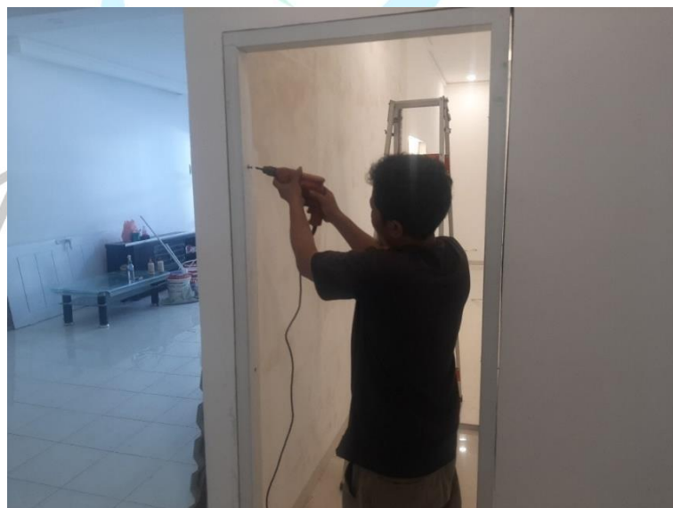
Gambar 3. 37 Pemasangan Pintu Kamar Utama Dokumentasi Pribadi ,2022
