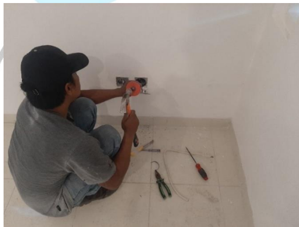
Gambar 3. 24 Proses Pemasangan Stop Kontak Dokumentasi Pribadi ,2022
