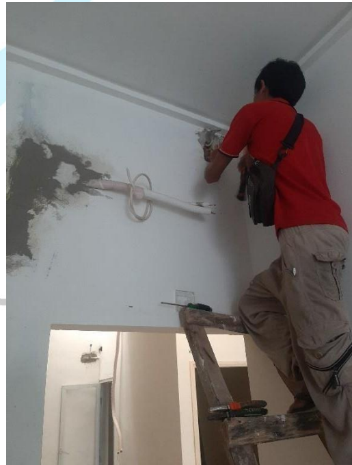
Gambar 3. 25 Proses Pemasangan Stop Kontak
