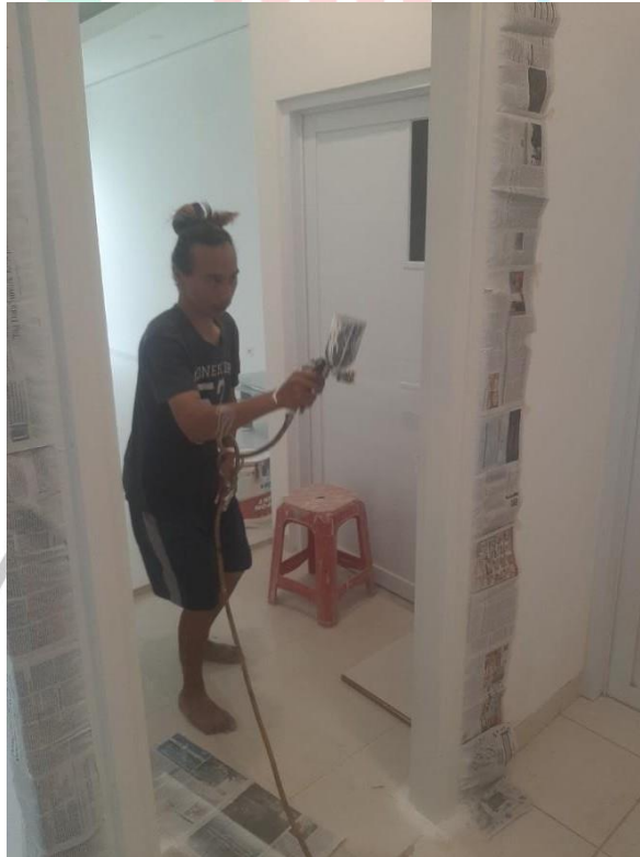
Gambar 3. 40 Proses Pengecatan Pintu Kamar Utama Dokumentasi Pribadi ,2022
