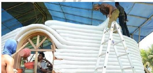
**Gambar 2. 4** Proses Konstruksi *Earth Bag Villa* 2019
