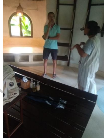
Gambar 4. 2 Inspeksi Earthbag Villa dengan Arsitek Mana Earthly Paradise Sumber : Dokumentasi Praktikkan
