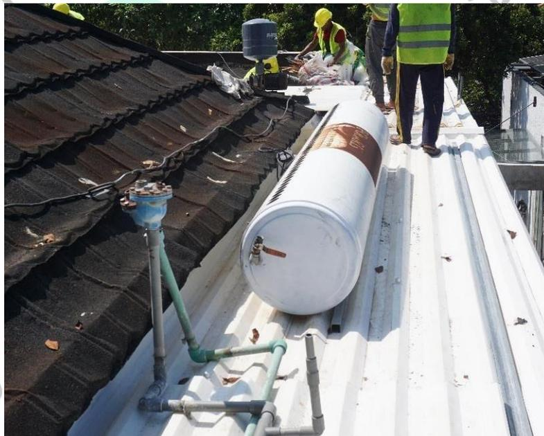
Gambar 3.1. 12 Solar heater yang telah di pindahkan
