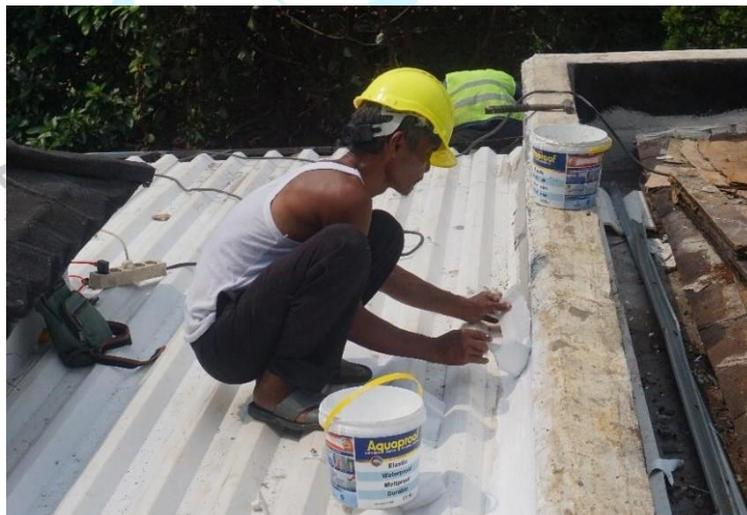
Gambar 3.1. 11 Pelapisan mortar dengan serat dan cat *waterproofing*
