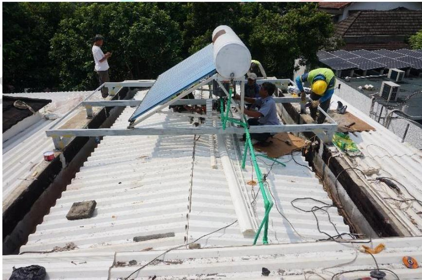
Gambar 3.1. 17 Penempatan Solar Heater ke rangka dudukan baru
