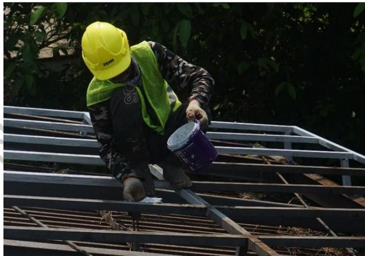
*Gambar 3.1. 5 Proses pengecatan rangka besi hollow (Sumber : Dokumentasi praktikkan 2022)*
