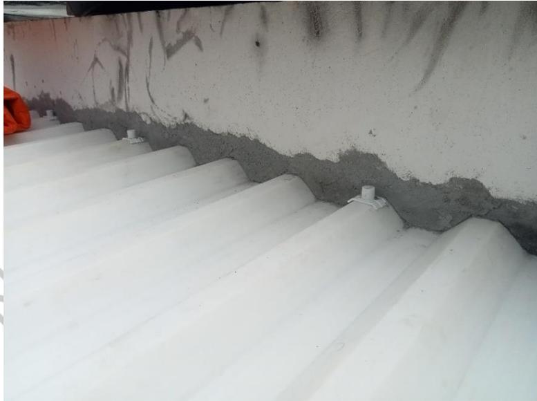
Gambar 3.1. 10 Bagian bobokan tembok yang sudah di tutupi semen mortar
