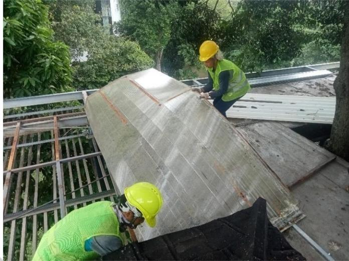
Gambar 3.1. 3 Pengelupasan atap polycarbonate (Sumber : Dokumentasi praktikkan 2022)
