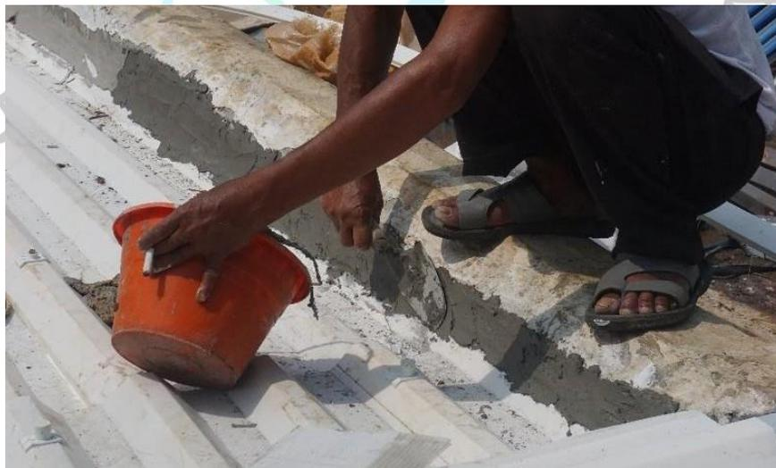
Gambar 3.1. 9 Penutupan tembok yang di bobok dengan semen mortar (Sumber : Dokumentasi praktikkan 2022)
