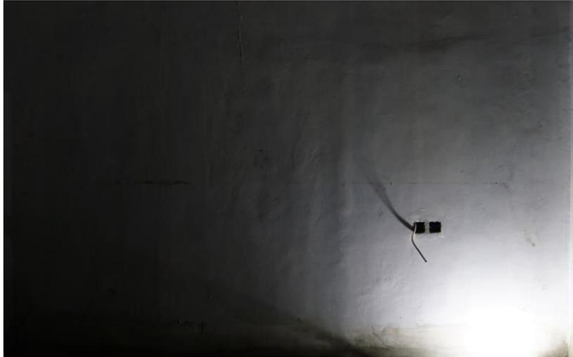
Gambar 3.2. 3 Acian dinding yang bergelombang saat di sorot lampu
