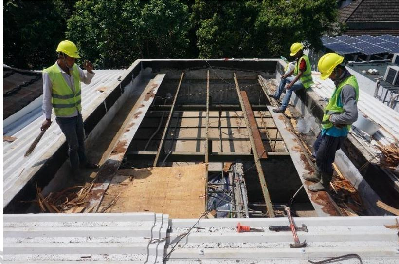
Gambar 3.1. 13 Proses pembongkaran atap bitumen ruang perpustakaan (Sumber : Dokumentasi praktikkan 2022)
