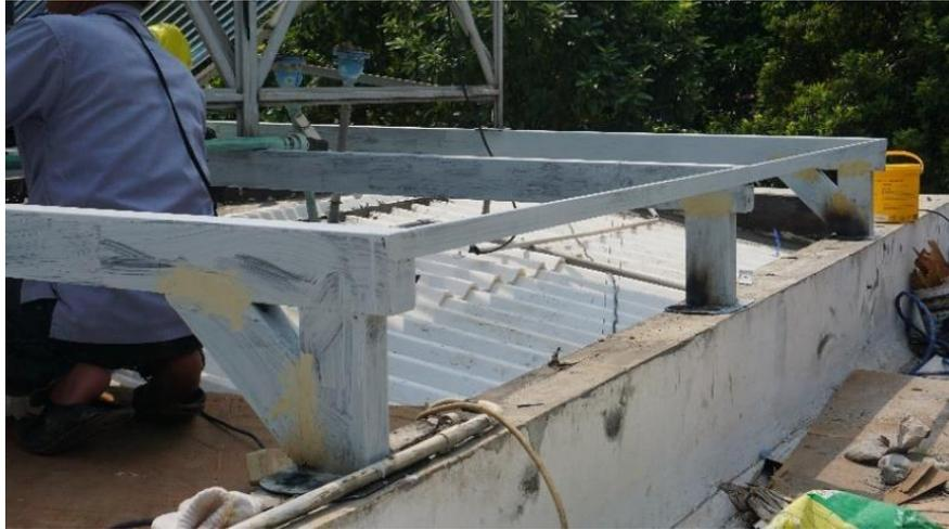
Gambar 3.1. 16 Struktur rangka dudukan untuk pemanas
