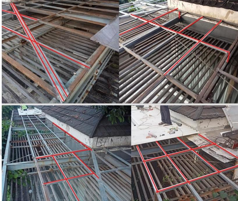
Gambar 3.1. 19 Foto penanda rangka besi yang diganti
