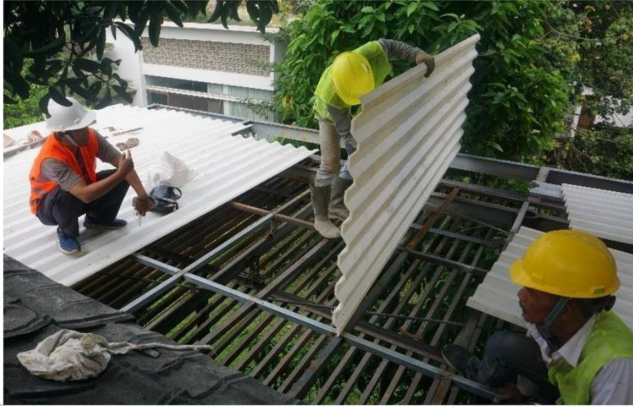
Gambar 3.1. 8 Proses pemasangan atap PVC pada rangka besi
