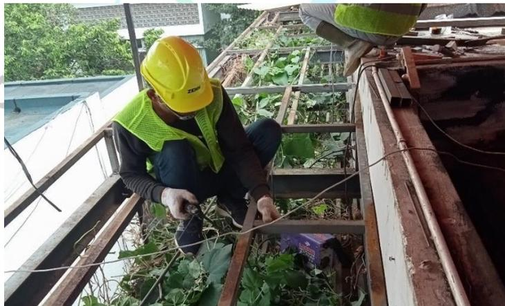
Gambar 3.1. 4 Proses Pengelasan rangka besi hollow (Sumber : Dokumentasi praktikkan 2022)
