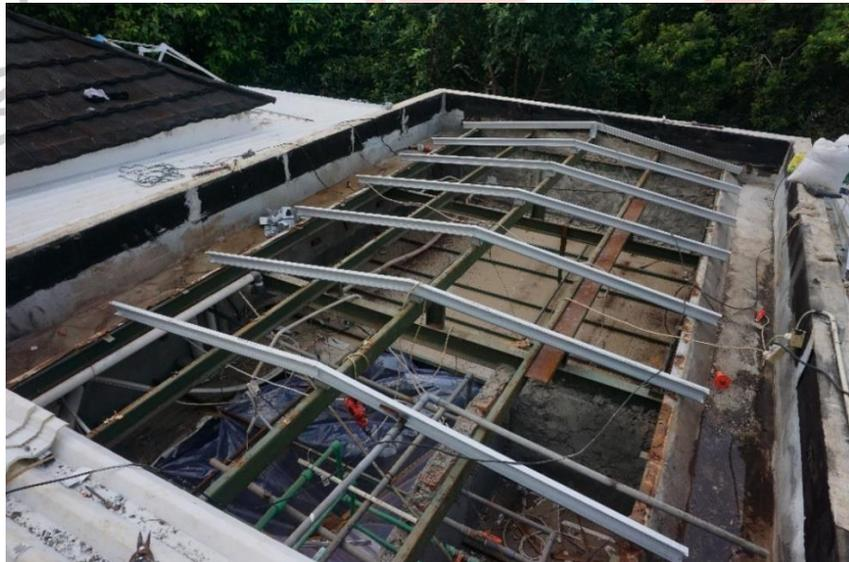
Gambar 3.1. 14 Proses Penyusunan rangka baja ringan ruang perpustakaan (Sumber : Dokumentasi praktikkan 2022)
