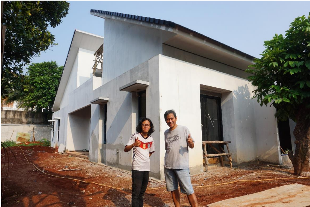
Lampiran B. 2 Praktikan saat melakukan Kerja Profesi pada proyek pembangunan Rumah tinggal Gempol
