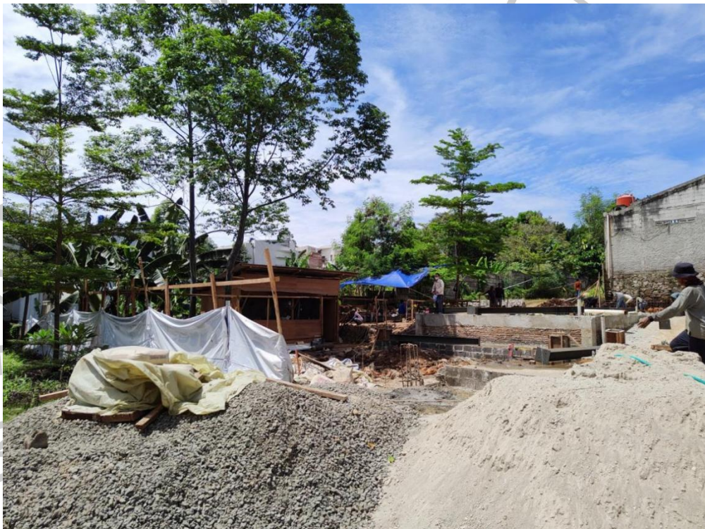
Gambar 3.21 Pembangunan Lab Desain Produk(1)
