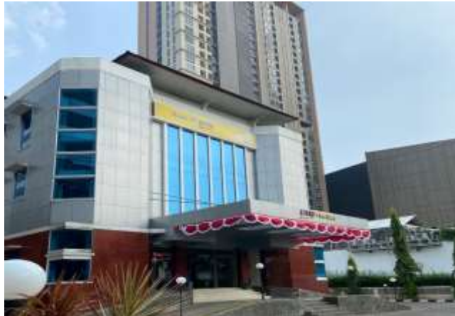
Gambar 1.1 Bank BTN Kantor Cabang Bintaro Jaya (Sumber : Dokumentasi Pribadi)
