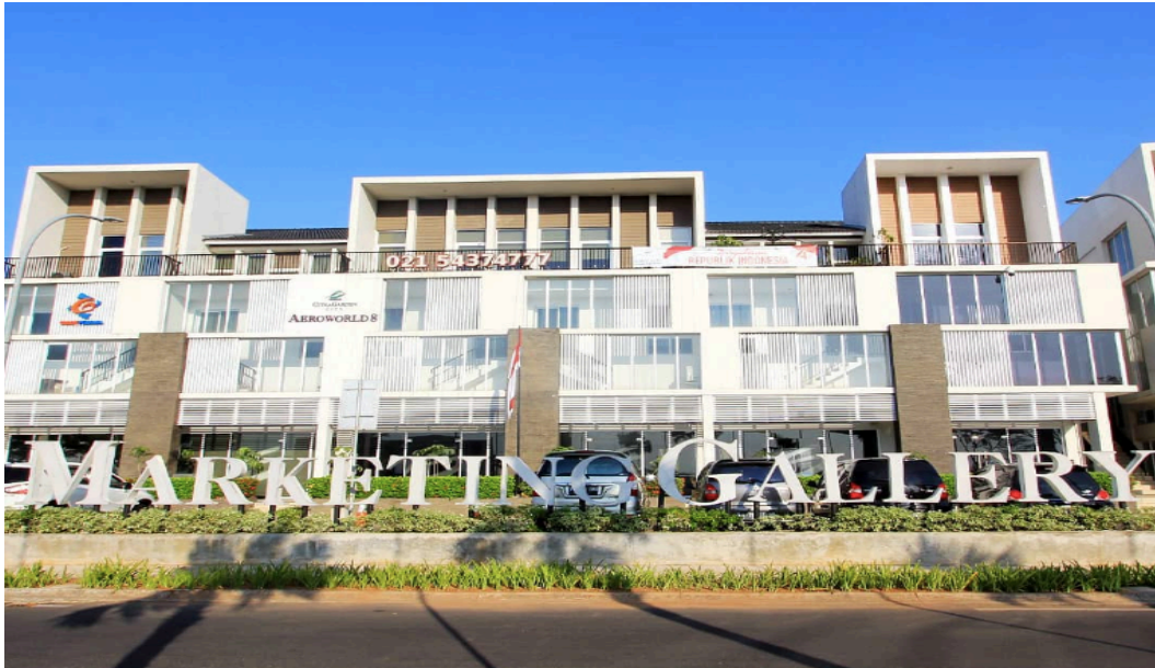
Gambar 1.1 Lokasi Kantor PT. Ciputra Development, Tbk Cabang Jakarta Barat Sumber :
