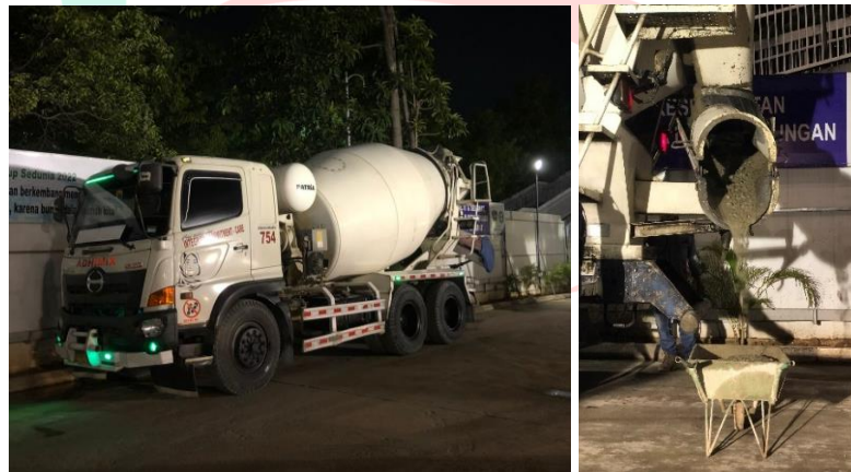
Gambar 3.11 Truck Mixer dan beton ready mix (Dokumentasi Pribadi, 2022)
