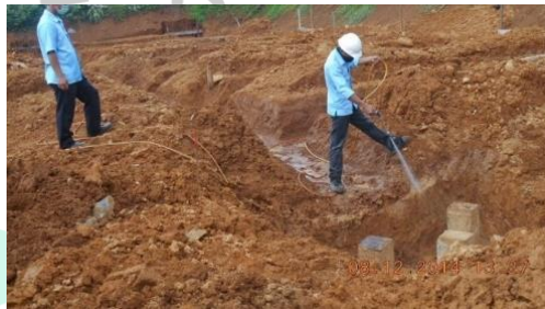
Gambar 3.51 Ilustrasi penyemprotan termitisida (Dokumen proyek KSO PT PP (Persero) Tbk – PT Arkonin, 2022)
