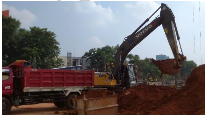
Gambar 3.17 Excavator dan dump truck (Dokumentasi Pribadi, 2022)
