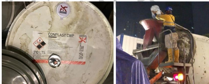
Gambar 3.13 Pencampuran admixture integral dengan beton ready mix (Dokumentasi Pribadi, 2022)
