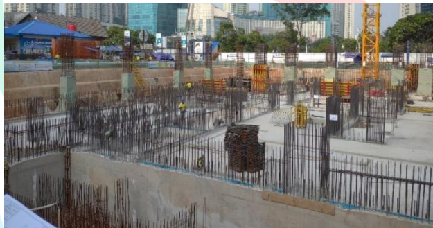
Gambar 3.67 Pelaksanaan pekerjaan raft foundation telah selesai (Dokumentasi Pribadi, 2022)
