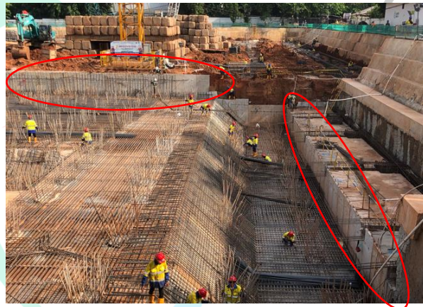
Gambar 3.44 Hasil pemasangan bekisting precast beton (Dokumentasi Pribadi, 2022)
