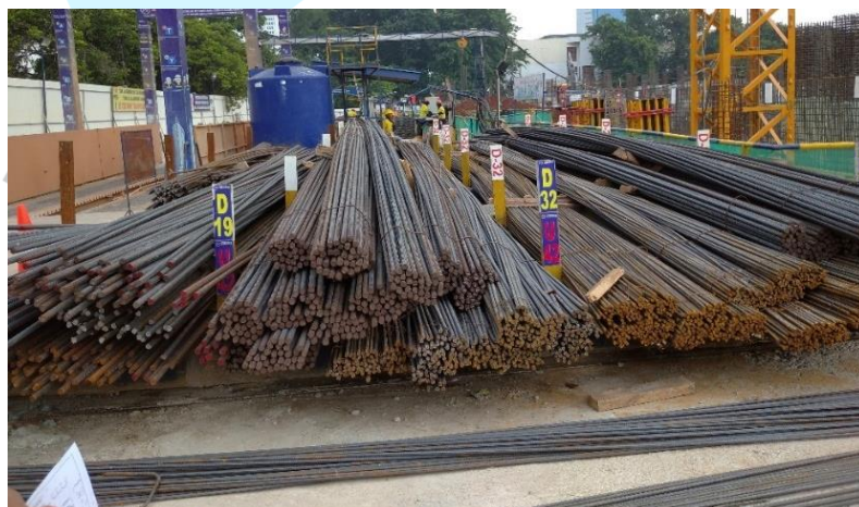
Gambar 3.10 Stockyard tulangan baja (Dokumentasi Pribadi, 2022)
