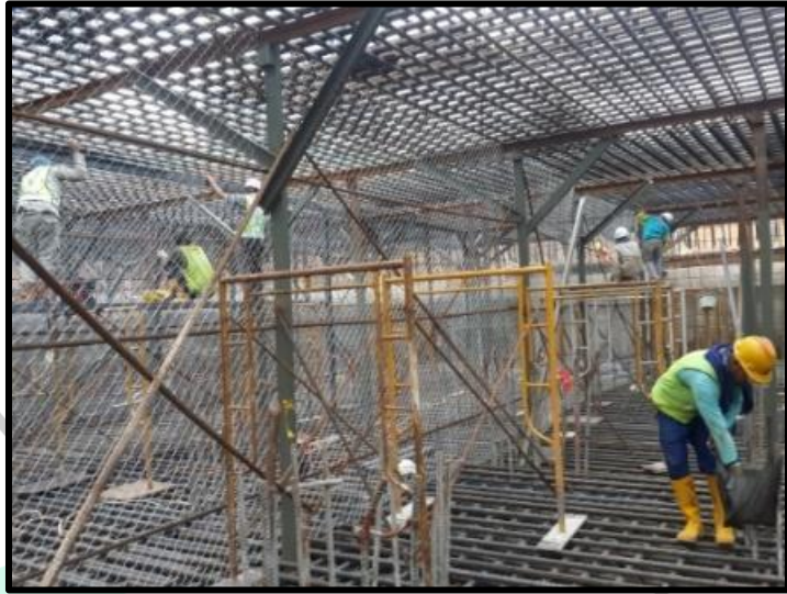
Gambar 3.47 Pemasangan tiang besi penyangga dan kawat harmonika raft foundation (Dokumentasi Pribadi, 2022)
