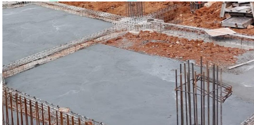
Gambar 3.37 Contoh hasil lantai kerja dan pasir urug (Dokumen proyek KSO PT PP (Persero) Tbk – PT Arkonin, 2022)
