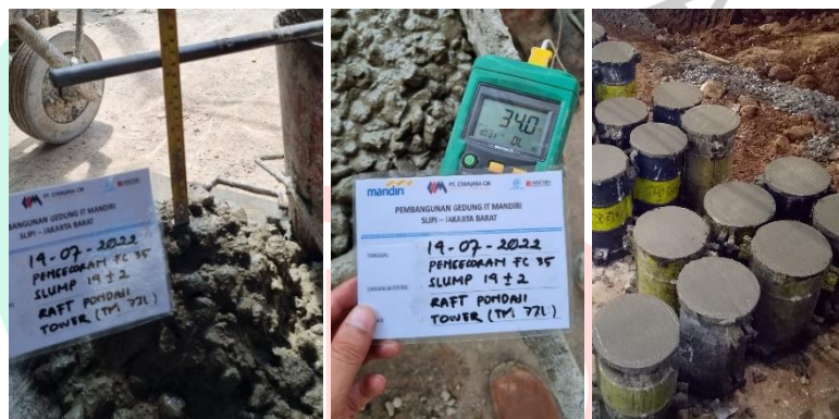
Gambar 3.59 Pemeriksaan beton dan benda uji raft foundation (Dokumentasi Pribadi, 2022)
