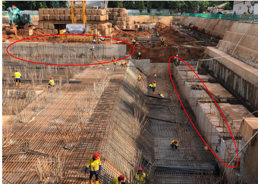
Gambar 3.21 Bekisting precast beton untuk raft foundation (Dokumentasi Pribadi, 2022)
