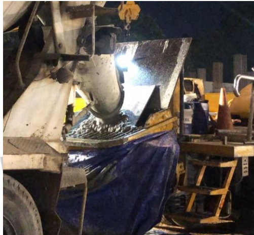
Gambar 3.60 Penuangan beton segar pada truck mixer - concrete pump (Dokumentasi Pribadi, 2022)
