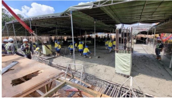
Gambar 3.65 Pelaksanaan pekerjaan pengecoran raft foundation (Dokumentasi Pribadi, 2022)
