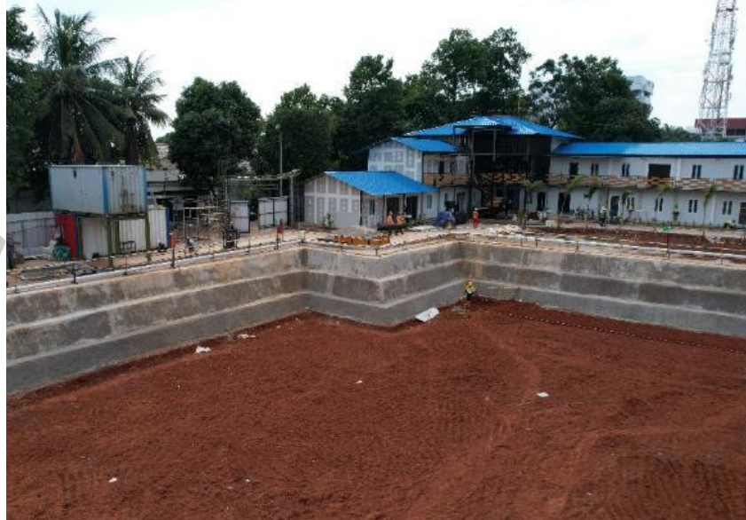
Gambar 3.31 Hasil area galian proyek (Dokumen proyek KSO PT PP (Persero) Tbk – PT Arkonin, 2022)
