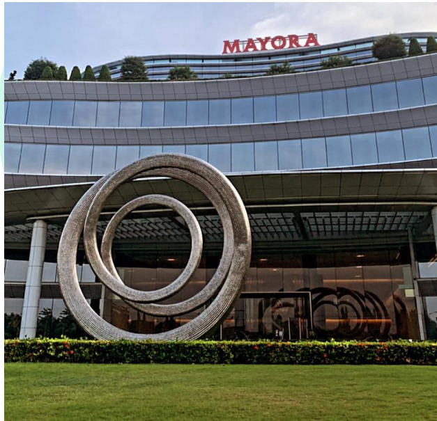
Gambar 1.1 Gedung kantor PT Mayora Indah Tbk.
