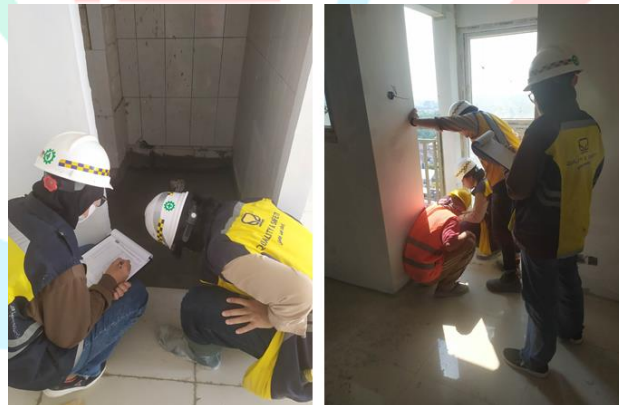
Gambar 3. 22 Praktikan saat melakukan tes rendam (Sumber : Dokumentasi pribadi)
