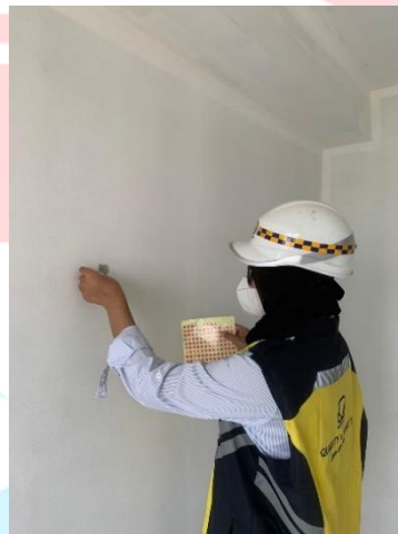
Gambar 3. 25 Inspeksi pekerjaan dinding (Sumber : Dokumentasi pribadi)
