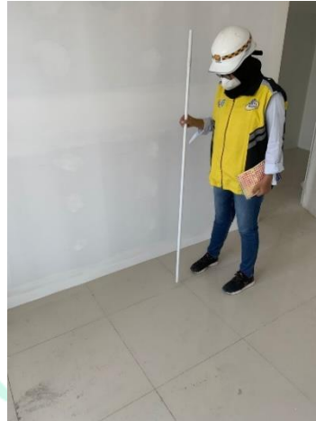
Gambar 3. 26 Inpeksi pekerjaan keramik lantai (Sumber : Dokumentasi pribadi)
