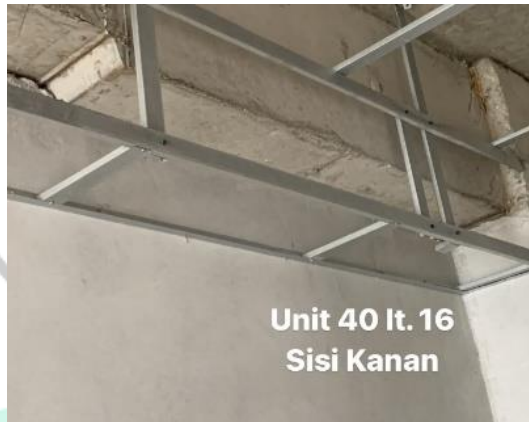
Gambar 3. 11 Foto kerangka drop ceiling pada unit 40 lantai 16 sisi kanan yang sudah dipasang (Sumber : Dokumentasi pribadi)
