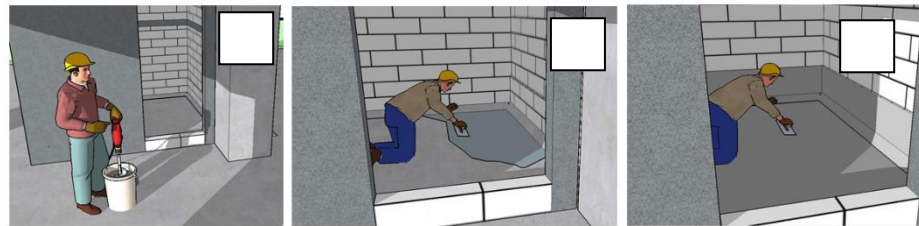
Gambar 3. 21 Proses pelaksanaan pekerjaan waterproofing (Sumber : google.com)
