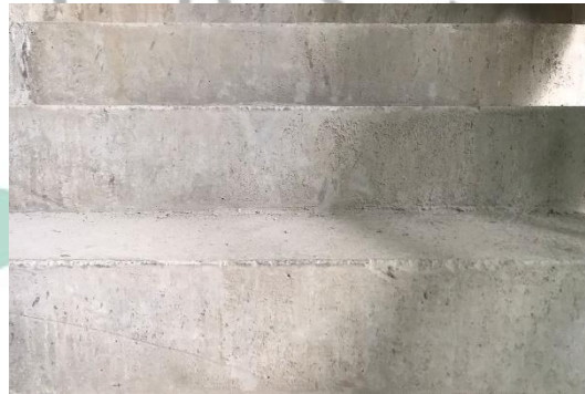
Gambar 3.62 Hasil Beton dengan Menggunakan Aluminium Formwork
