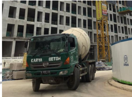
Gambar 3.22 Concrete Mixer Truck Sumber: Dokumentasi Pribadi (2022)
