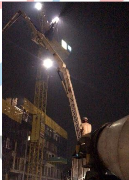
Gambar 3.23 Concrete Pump Sumber: Dokumentasi Pribadi (2022)
