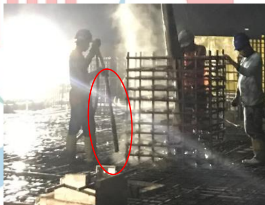
Gambar 3.27 Penggunaan Concrete Vibrator saat Pelaksanaan
