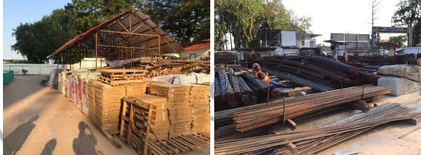
Gambar 3.7 Stockyard Material Sumber: Dokumentasi Pribadi (2022)
