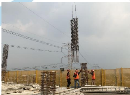
Gambar 3.54 Pekerjaan Pembesian Vertikal
