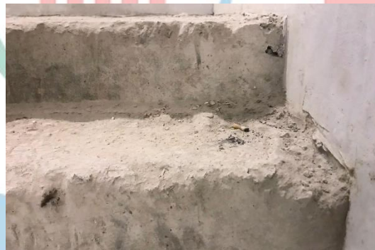
Gambar 3.63 Hasil Beton dengan Menggunakan Bekisting Konvensional
