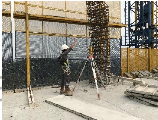
Gambar 3.53 Proses Marking oleh Surveyor
