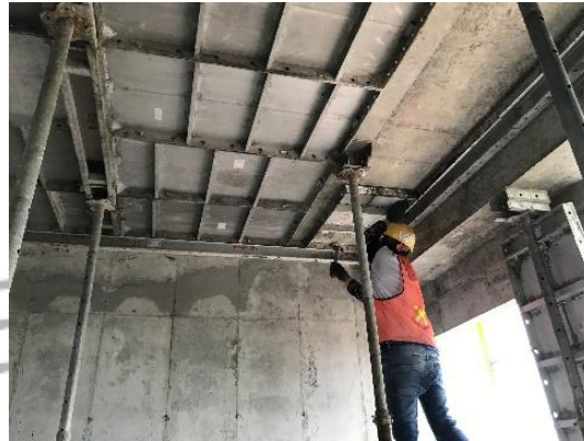
Gambar 3.61 Pembongkaran Bekisting
