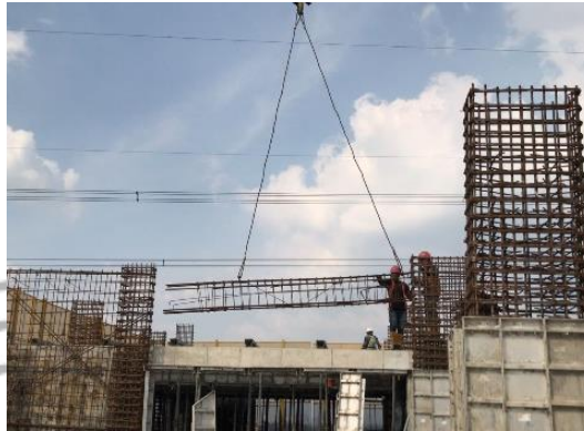
Gambar 3.58 Pekerjaan Pembesian Horizontal
