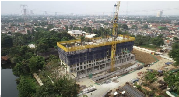
Gambar 1.2 Pembangunan Proyek Apartemen Sudimara Forestwalk Tower Albizia
