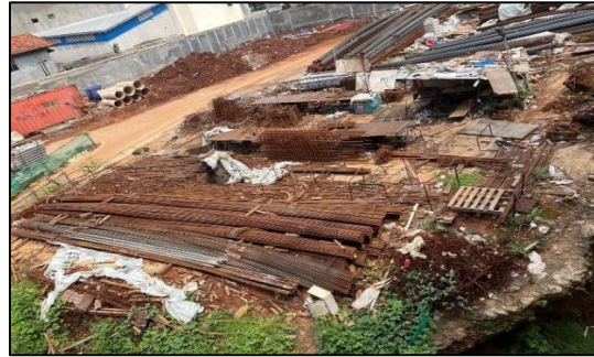
Gambar 3.4 Fabrikasi Baja Tulangan
