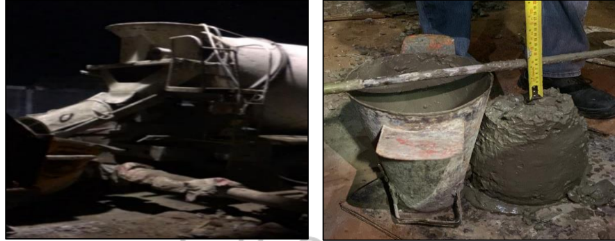
Gambar 3.3 Beton Ready Mix dan Slump Test f_c' 45
