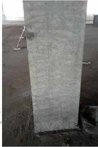
Gambar 3. 13 Beton yang Sudah Di Repair.
