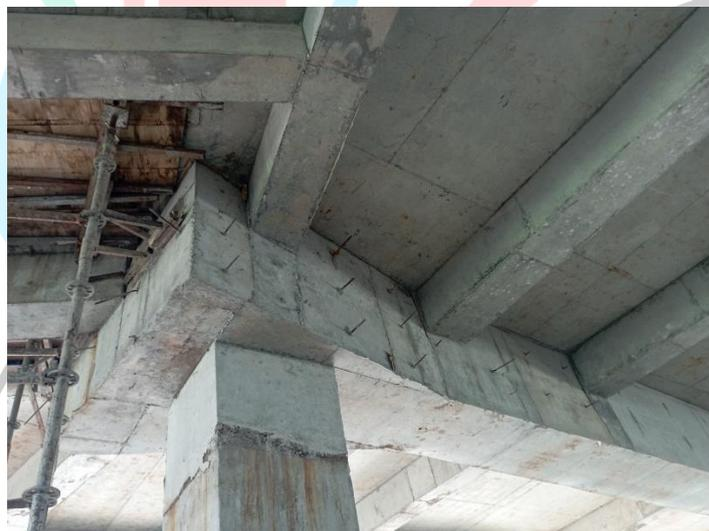
**Gambar 3. 23 Pelepasan Bekisting.**
