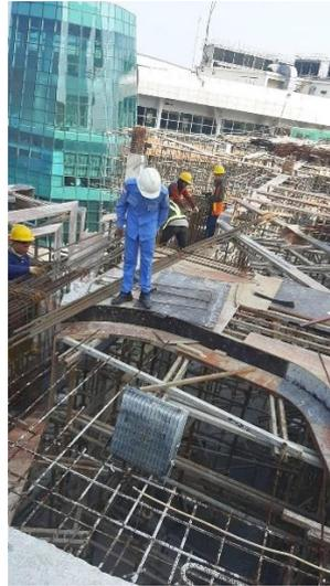
**Gambar 3. 15 Pembesian Pada Balok.**
