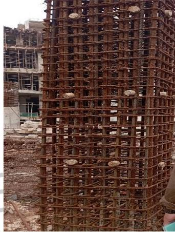
Gambar 3. 10 Pemasangan *Decking* Beton.
