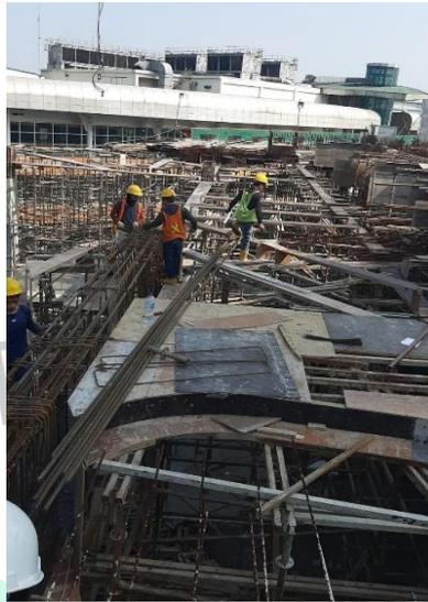
**Gambar 3. 14 Pemasangan Bekisting Plat Lantai.**
