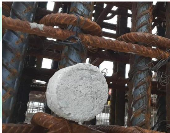
Gambar 3. 5 Decking Beton.
