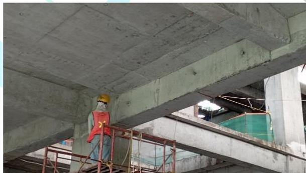
Gambar 3. 24 Repair Plat dan Balok.
