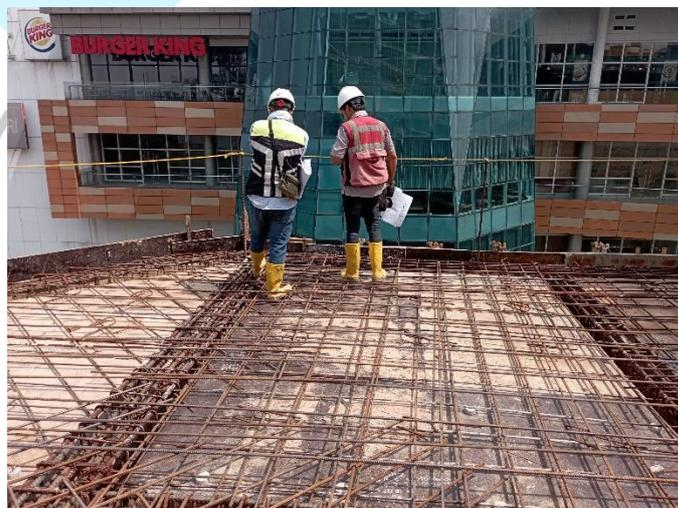
**Gambar 3. 19 Pengecekan Penulangan.**
