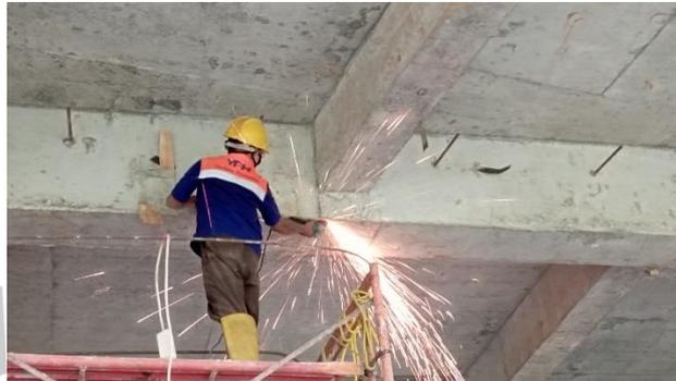
Gambar 3. 25 Proses Pemotongan Tie Rod.
