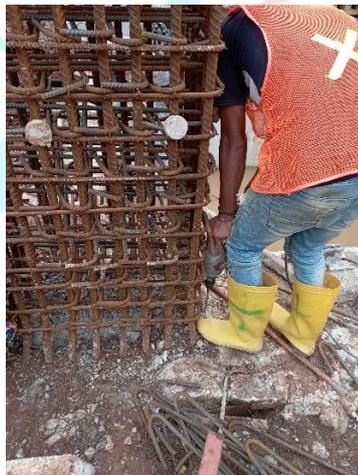
Gambar 3. 8 Pemasangan Marking Kaki Kolom.
