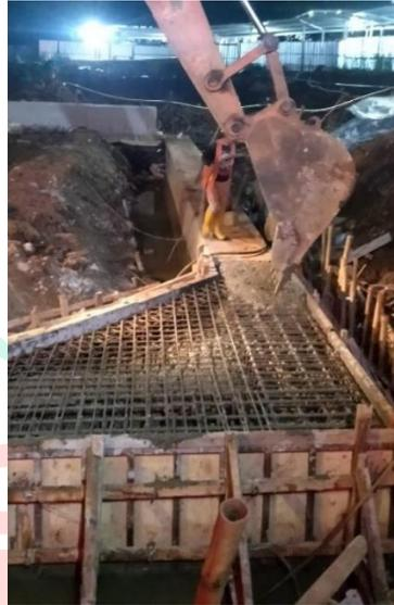
Gambar 3. 21 Pengecoran Plat Lantai.
