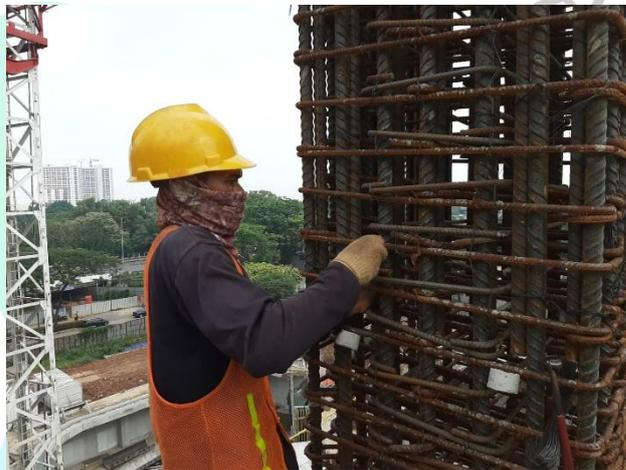
**Gambar 3. 9 Pemasangan dan Pengecekan Tempat Kolom.**
