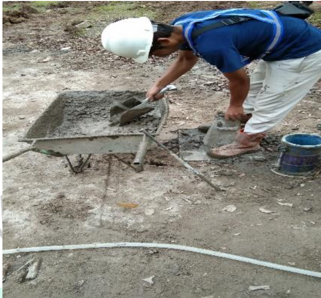
Gambar 3. 28 Pemasukan Beton Ke Corong
