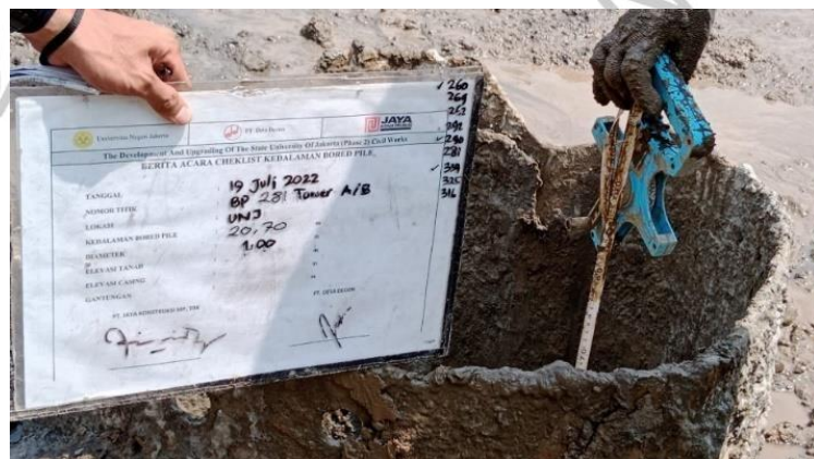
Gambar 3. 22 Pengukuran kedalaman bored pile
