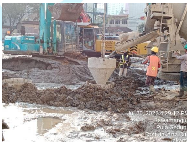
Gambar 3. 31 Pengecoran Awal
