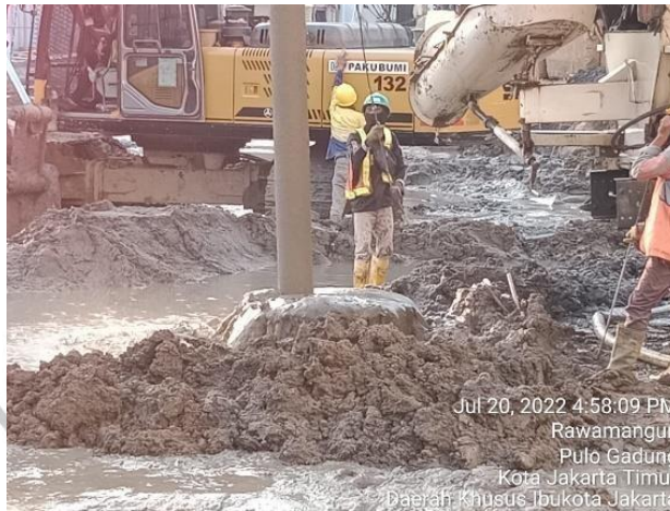
Gambar 3. 32 Pengecoran Akhir
