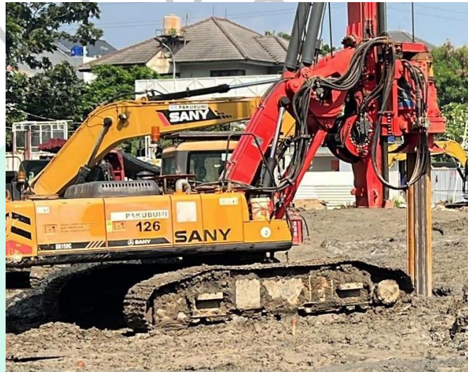
Gambar 3. 21 Pengeboran titik pondasi bored pile
