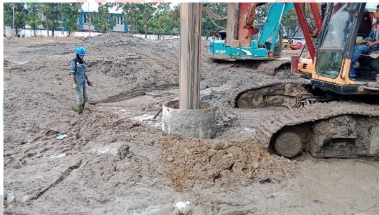
Gambar 3. 24 Cleaning pada temporary casing
