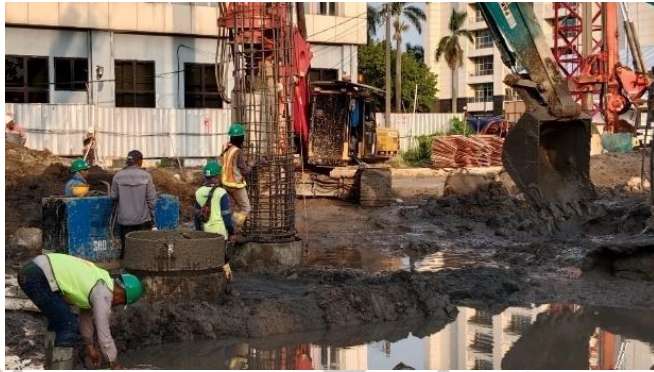
Gambar 3. 26 Instalasi Tulangan Besi
