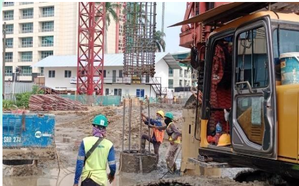
Gambar 3. 27 Instalasi Tulangan Besi
