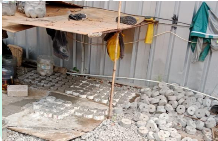
Gambar 3. 19 Lokasi pengolahan decking beton
