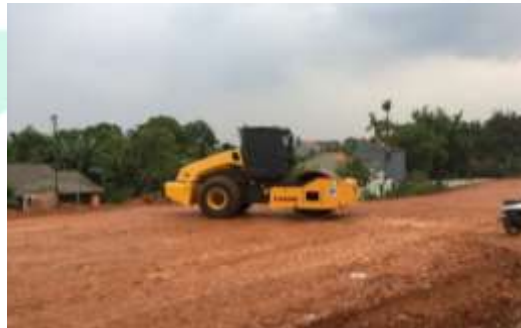
Gambar 3.32 Proses Pematatan Subgrade
