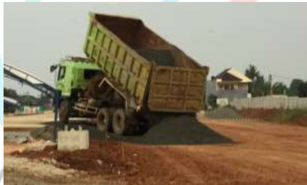
Gambar 3. 34 Proses Penumpahan Material Agregat
