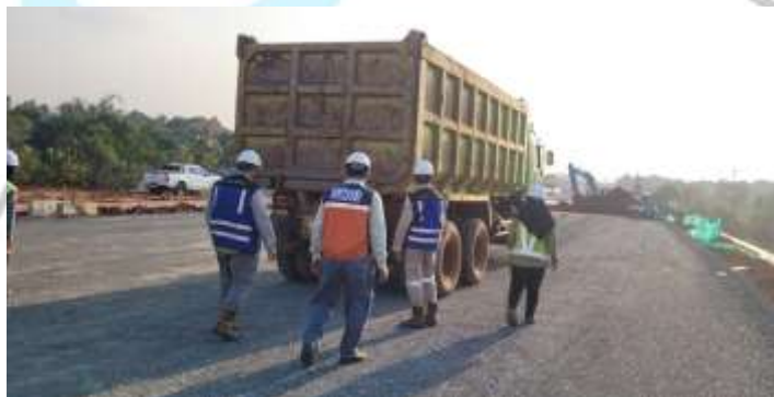
Gambar 3.36 Uji Proof Rolling pada LPA
