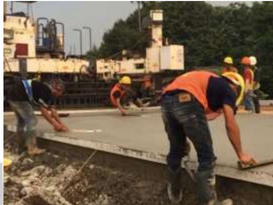
Gambar 3.43 Proses Perataan dengan Manual
