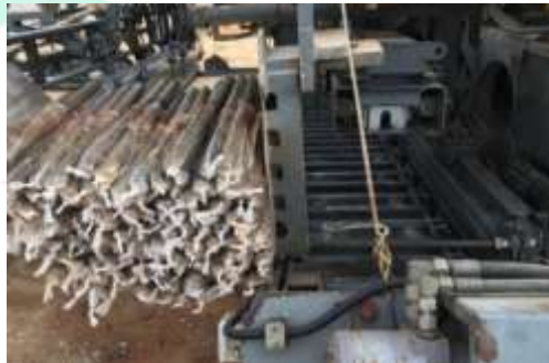
Gambar 3.39 Persiapan Dowel Bar Pada Mesin Concreat Paver
