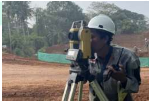
Gambar 3.30 Pengecekan Elevasi oleh Divisi Surveying
