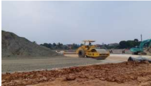
Gambar 3.35 Proses Pemadatan LPA
