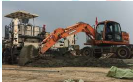
Gambar 3.42 Proses Penghamparan Beton dibantu Excavator
