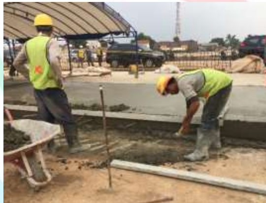
Gambar 3.44 Proses Pemasangan Tie Bar
