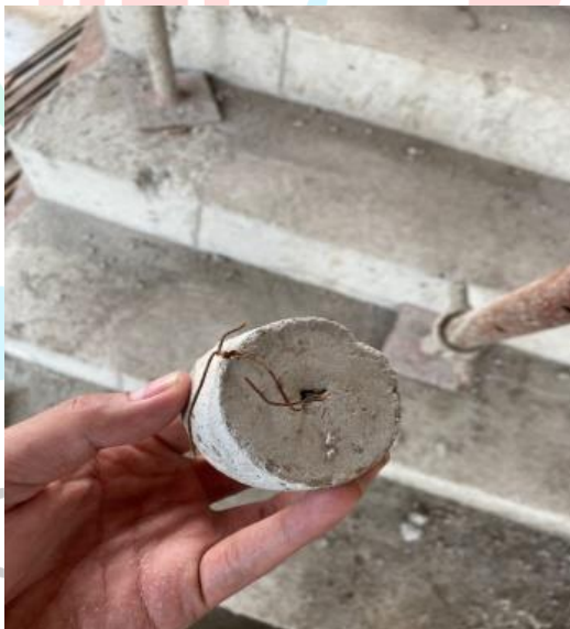
Gambar 3.9 Beton Decking (Dokumentasi pribadi Praktikan)
