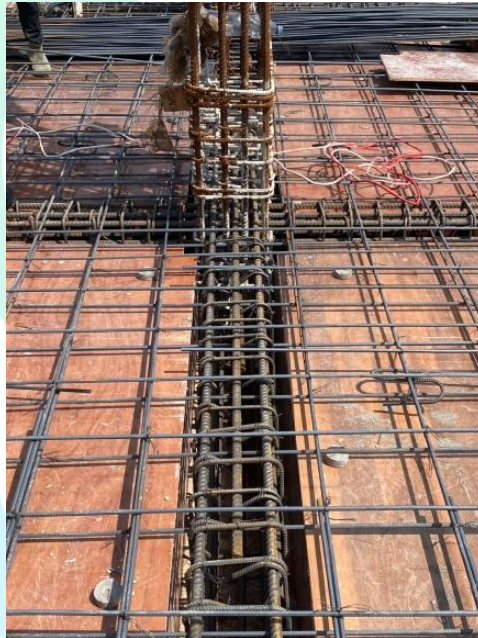
Gambar 3.22 Pemasangan Tulangan Balok di Proyek (Dokumentasi Pribadi Praktikan)
