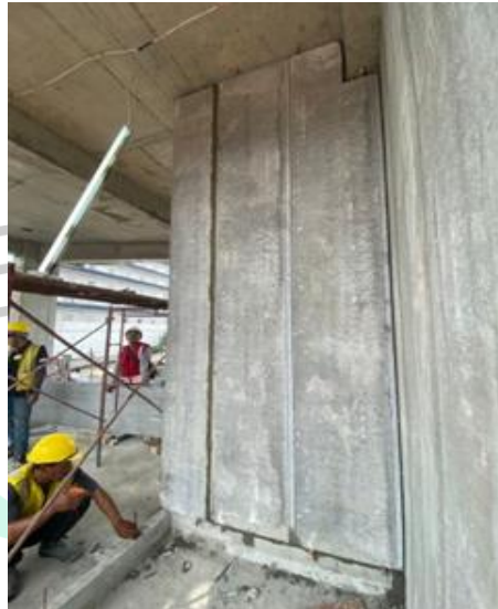
Gambar 3.10 Dinding Panel (Joe Green) (Dokumentasi pribadi Praktikan)
