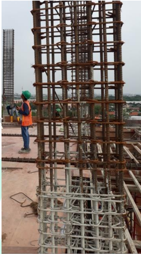
Gambar 3.23 Kolom di Proyek (Dokumentasi Pribadi Praktikan)
