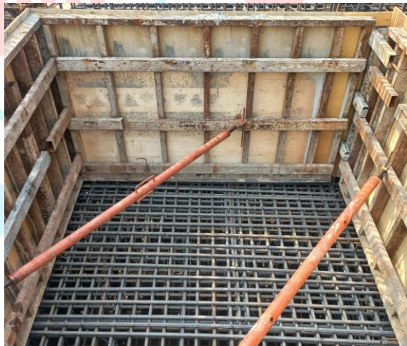
Gambar 3. 33 Pelaksanaan Bekisting Kayu (Sumber: Dokumen Pribadi)
