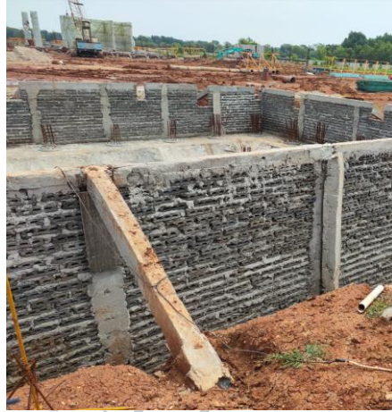
Gambar 3. 32 Pelaksanaan Bekisting Batako (Sumber: Dokumen Pribadi)
