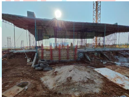
Gambar 3. 35 Pelaksanaan Pemasangan Tenda (Sumber: Dokumen Pribadi)
