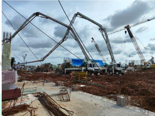
Gambar 3. 19 Concrete Pump (Sumber: Dokumen Pribadi)
