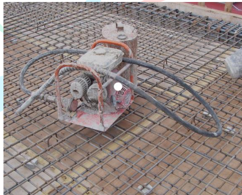
Gambar 3. 21 Vibrator Concrete (Sumber: Dokumen Pribadi)
