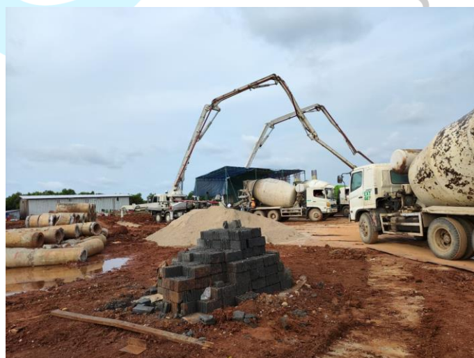
Gambar 3. 8 Beton Ready Mix (Sumber: Dokumen Pribadi)
