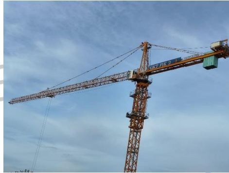
Gambar 3. 15 Tower Crane (Sumber: Dokumen Pribadi)
