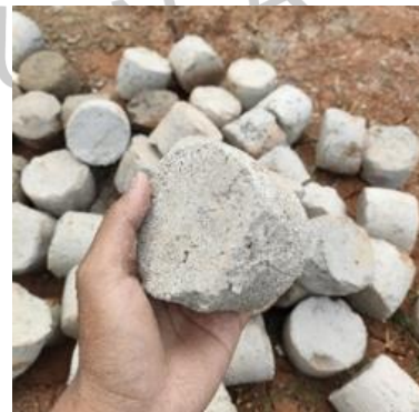
Gambar 3. 10 Decking Beton (Sumber: Dokumen Pribadi)
