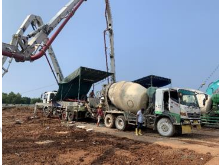
Gambar 3. 38 Pelaksanaan Pengecoran (Sumber: Dokumen Pribadi)
