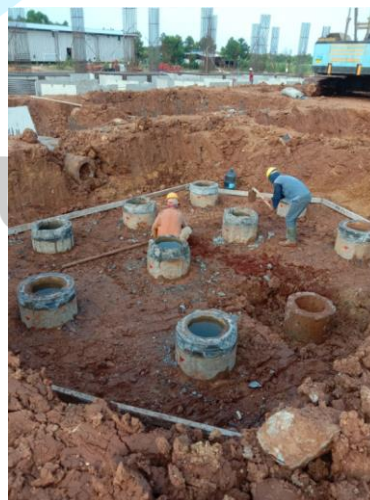
Gambar 3. 30 Pelaksanaan Pemotongan Kepala Spun Pile (Sumber: Dokumen Pribadi)
