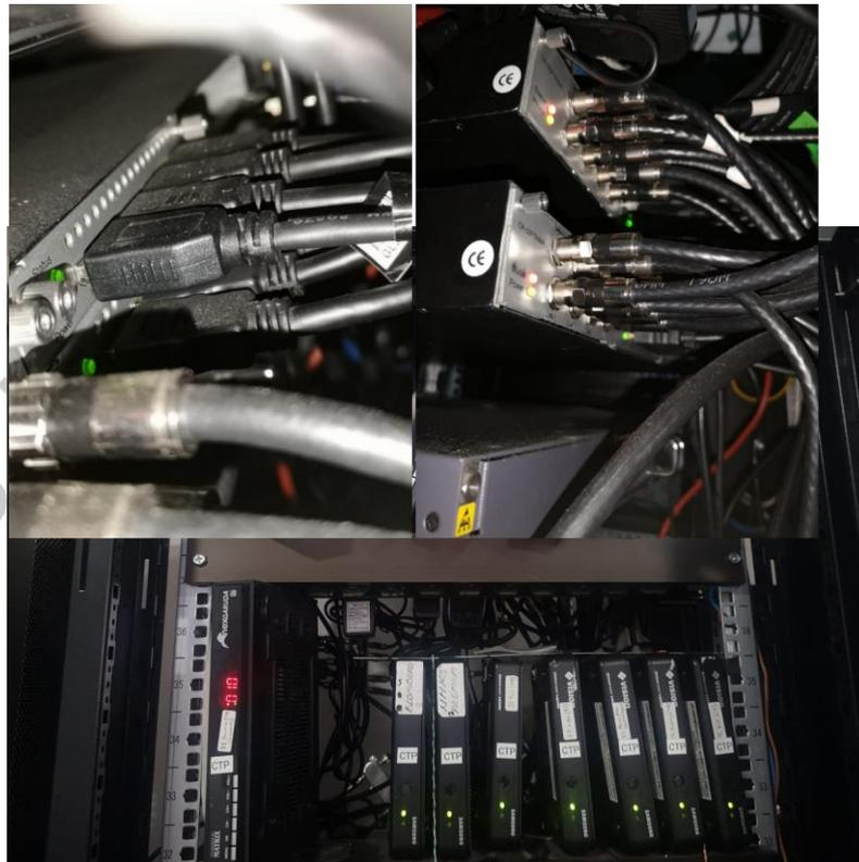
Gambar 3.16 berikut merupakan *input* dari parabola yang membawa sinyal digital yang dialirkan dengan kabel coaxial menuju *transmodulator* yang dicolokkan di bagian belakang alat sebagai *input*.
